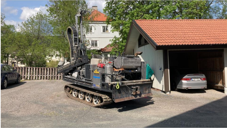
Jordprovtagning med geoteknisk borrhandsvagn
