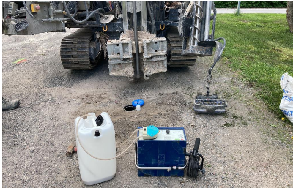
Renspumpning av grundvattenrör vid installation
