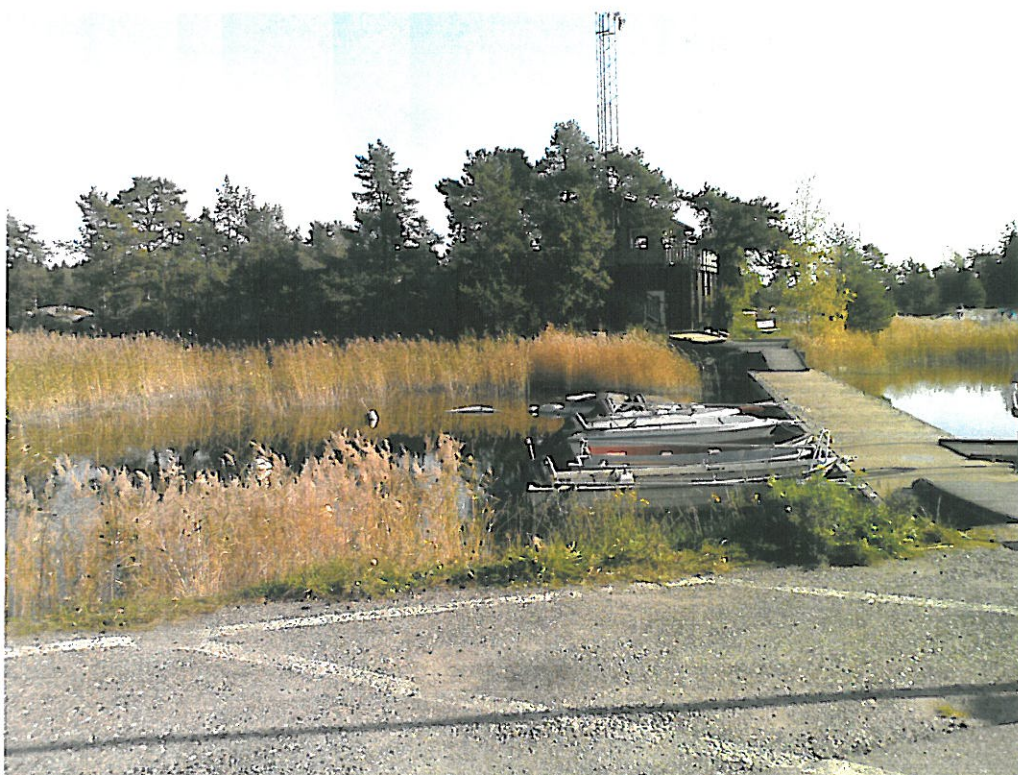
Principen för hur bryggorna anordnas är den samma som i befintligt hamnområde med en i land förankrad landgång som ligger löst på bryggan.
