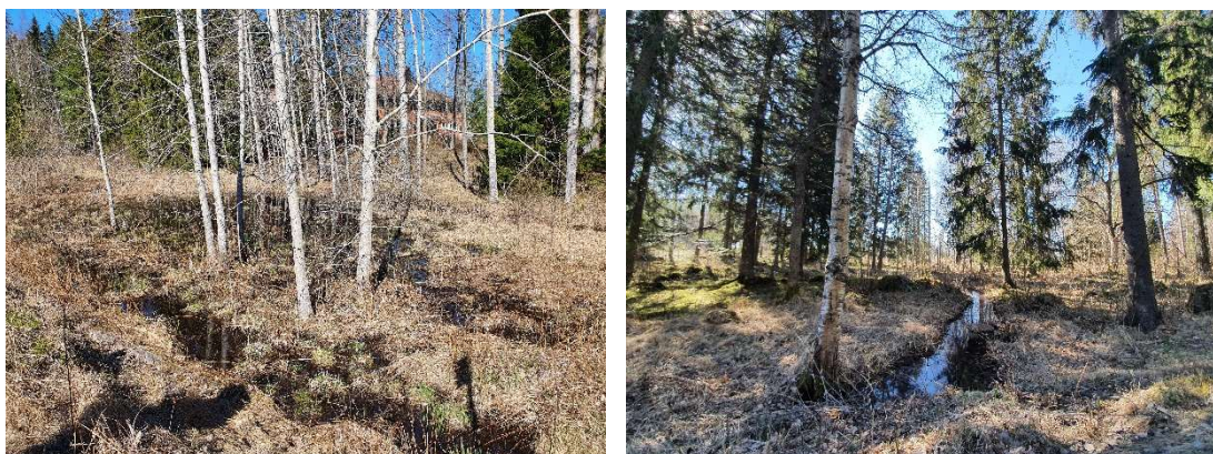
Figur 23. Till vänster: Foto från banvallen åt nordväst som visar stående vatten norr om banvallens kulvert, till vänster: Foto från Sandvägen åt söder som visar diket och markstrukturen.
