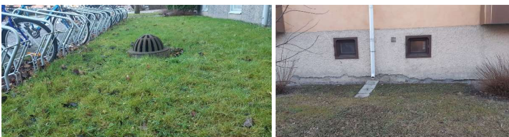
Till vänster: Översilningsyta med kupolbrunn. Till höger: Utkastare för takvatten. Foto: Tyréns
