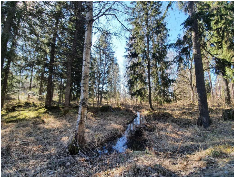
Figur 14. Dikessystemets slut, där vatten blir stående på grund av att Sandvägen är en barriär. Bild tagen från Sandvägen åt söder.
