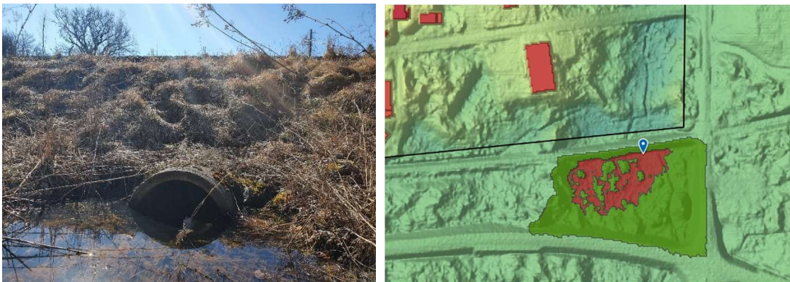
Figur 15. Till vänster: Kulvert som leder in vatten till område D från uppströms kalhygge söder om järnvägsspåret. Till höger: Avrinningsområdet uppströms kulverten.
