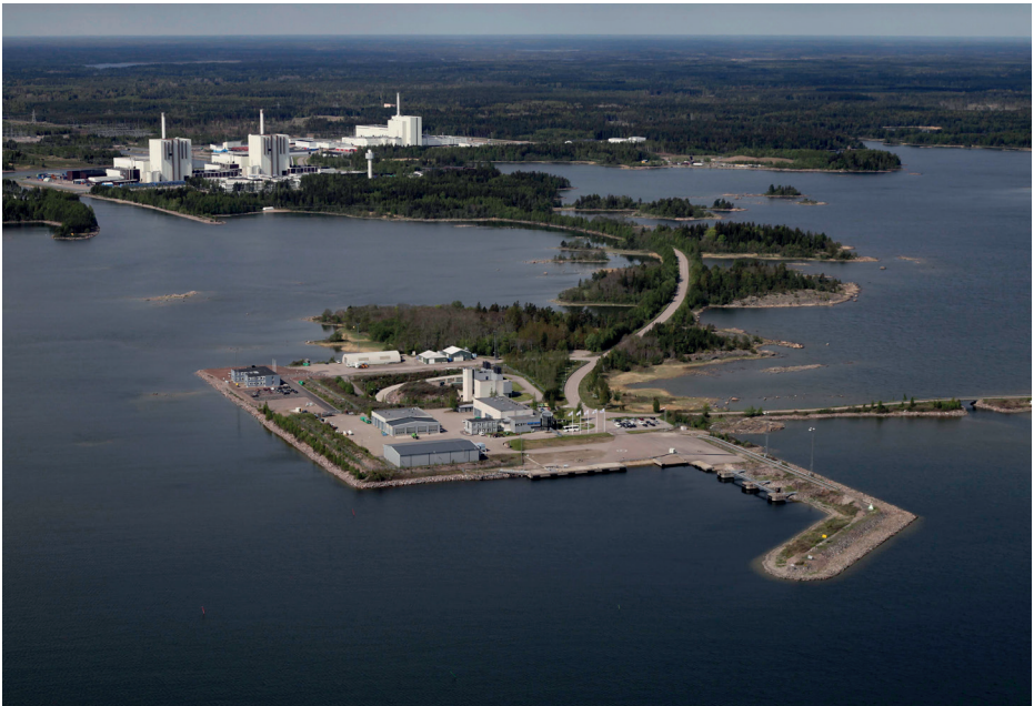
SFR flygvy öst - I Forsmark i Östhammars kommun ligger SKB:s anläggning SFR – Slutförvaret för kortlivat radioaktivt avfall. Det radioaktiva avfall som förvaras i SFR är låg- och medelaktivt. Det betyder att det till skillnad från använt kärnbränsle inte behöver kylas och att det är relativt kortlivat. SFR ligger 60 meter under Östersjöns botten och består av fyra 160 meter långa bergssalar och ett berggrum med en 50 meter hög betongsilo för det medelaktiva avfallet. Två parallella kilometerlånga tillfartstunlar förbinder anläggningen med markytan. Bild SKB. Foto Fotograf: Lasse Modin.
