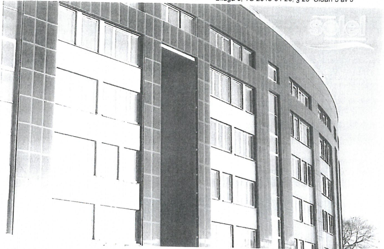
Frodeparken Uppsala hem. Nordens största solcellsfasad
