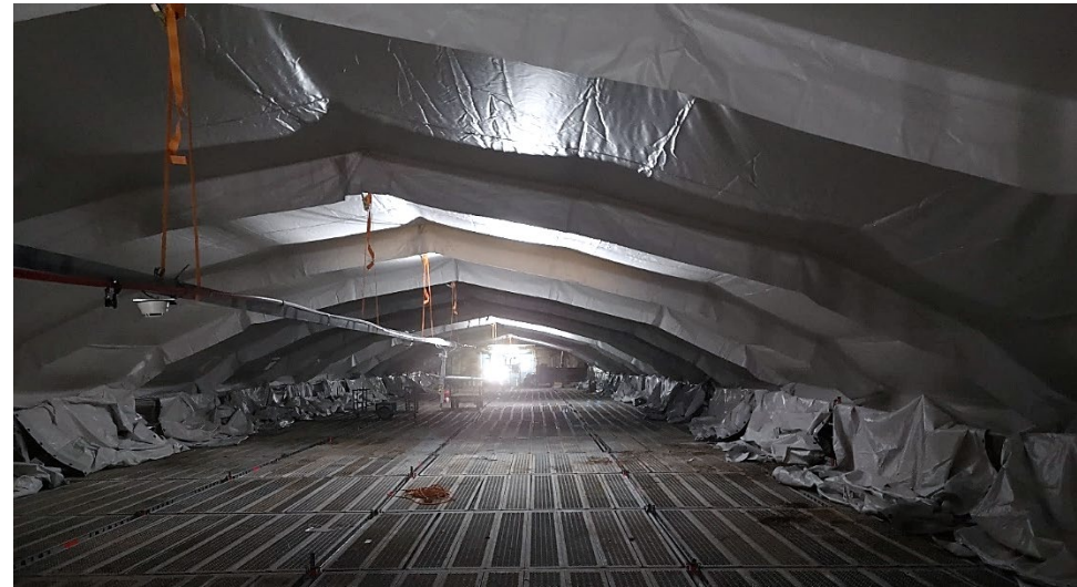
Bild 2: Pågående montage av tunnelduk, byggställning med ställningsgolv
