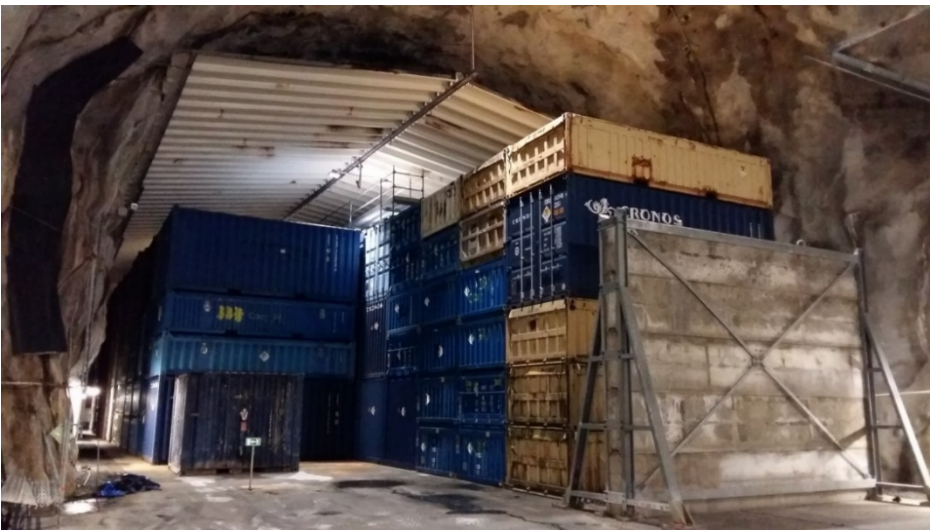
Bild 1: Med plåttak före montage av tunnelduk
