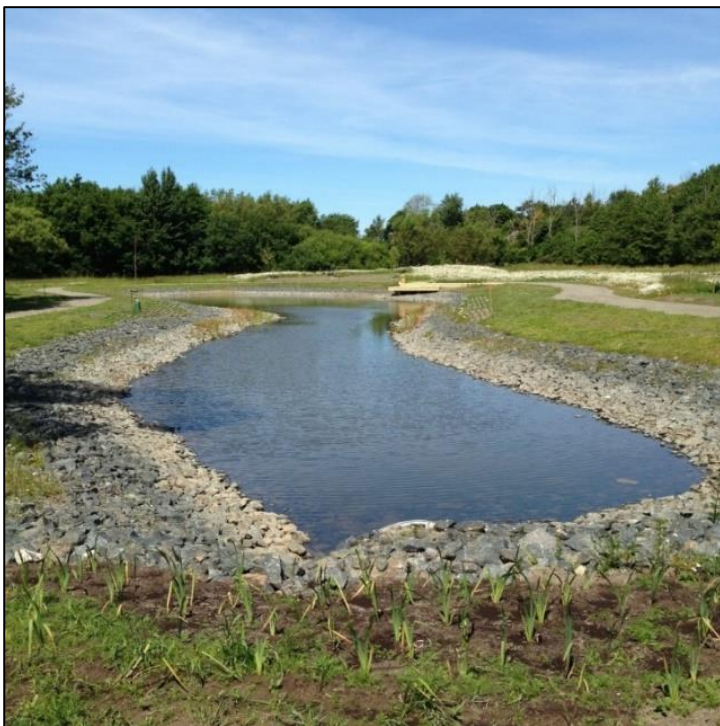
Figur 13. Exempel på dagvattendamm i Trönninge i Varberg. Foto: Norconsult
