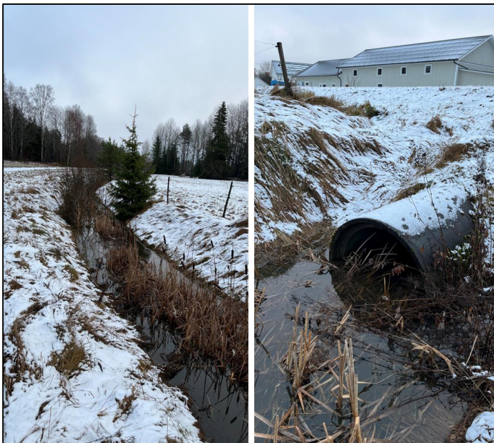
Figur 10. Befintligt dike i planområdes södra del
