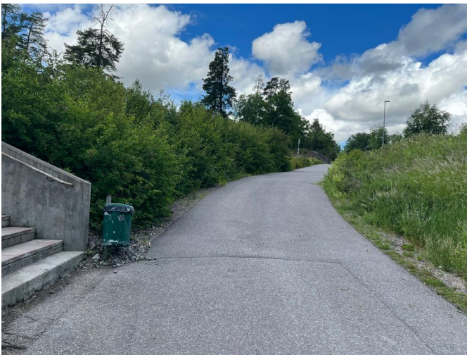
Figur 22. Trappa till busshållplats och gång- och cykelväg mot Marmavägen/Centrumvägen norr om tunneln.
