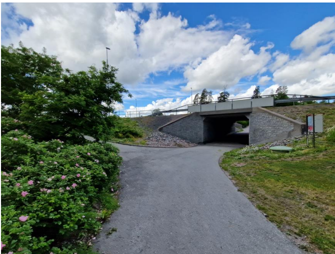
Figur 23. Gång- och cykelväg mot Hantverkarvägen samt pendlarparkering och busshållplats (vänster) söder om tunneln.
