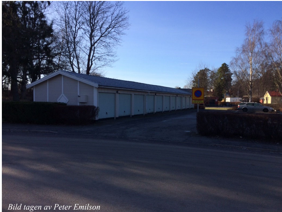
Garagebyggnad sedd från Köpmangatan.
