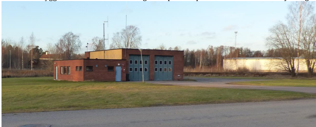
Nuvarande brandstation sedd från Vilhelm Haglunds väg. Den vita byggnaden till höger hör till Gimo industricenter som ligger på andra sidan järnvägen.
