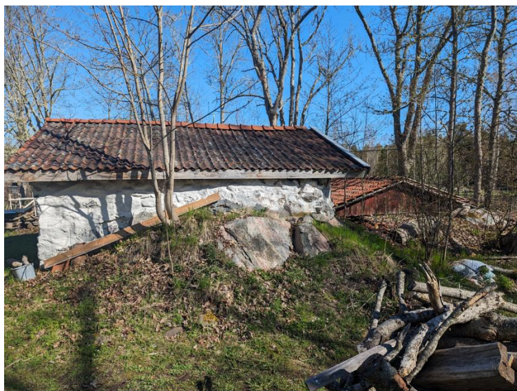
Figur 9. Långsidan av stenkällaren, jordkällarens tak syns till höger. Foto från platsbesök 2024-05-10.
