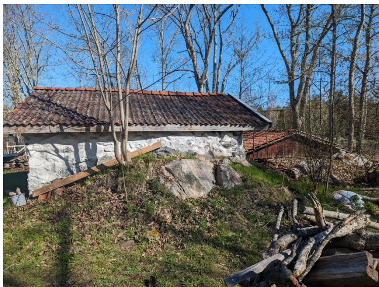
Figur 9. Längsidan av stenkällaren, jordkällarens tak syns till höger. Foto från platsbesök 2024-05-10.
