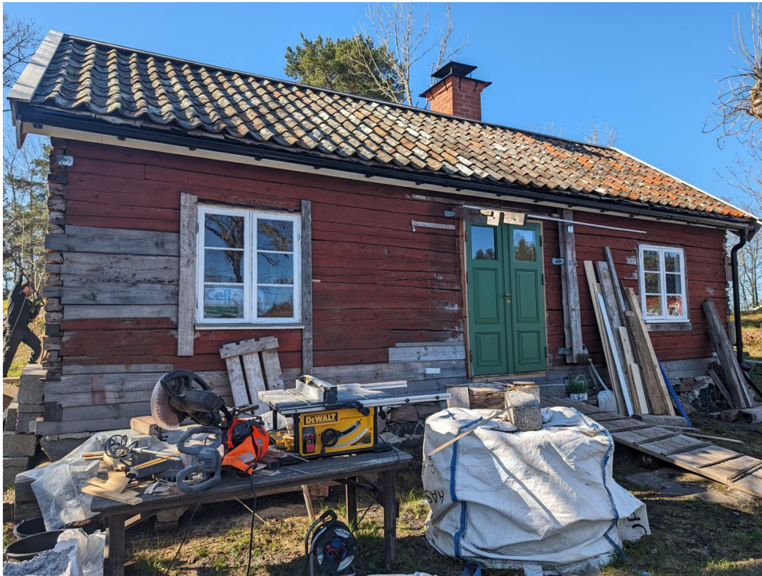
Figur 10. Framsidan på bagarstugan med nytillverkad ytterdörr och fönster. Dörren är en reproduktion av den gamla dörren och fönstren har handblåst glas. Foto från platsbesök 2024-05-10.
