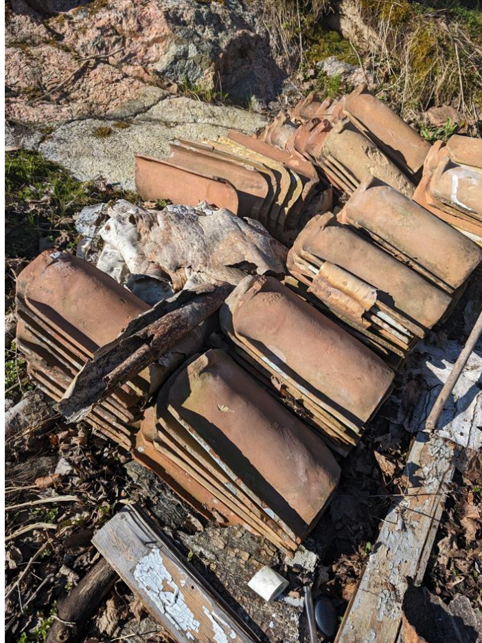
Figur 6. De äldsta tegelpannorna är märkta på undersidan med årtal och namn på tillverkaren.
