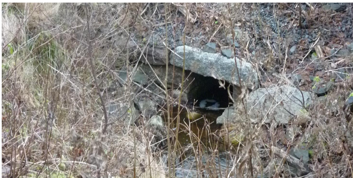
Diket leds genom en trumma genom järnvägsbanken
