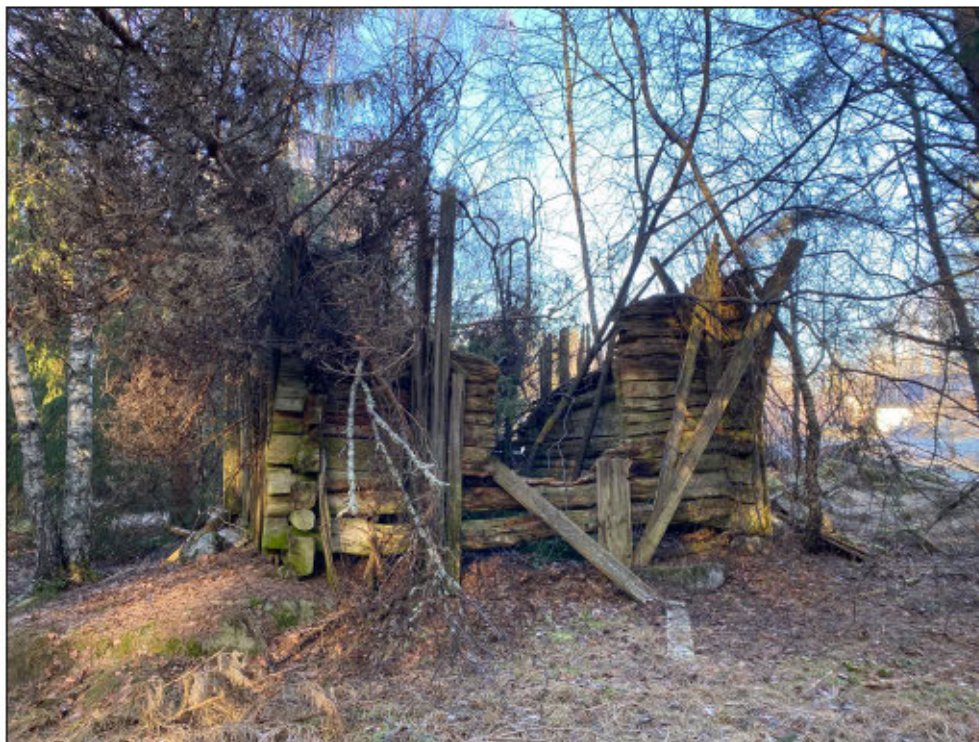
Figur 10. Objekt 1, den historiska husgrunden på berg i dagen. Foto från öster.
