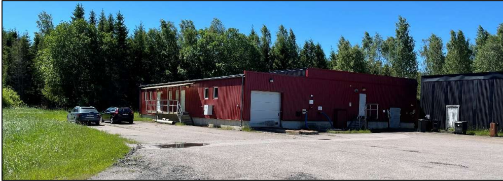
Figur 3.1. Infart till det befintliga reningsverket. Område B till vänster och område A till höger.
