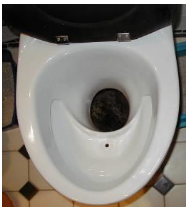
Figur 29. Exempel på urinsortande torrtoalett i porslin samt uppsamlingsbehållare för fekalier placerad i kryppgrund under toaletten.
