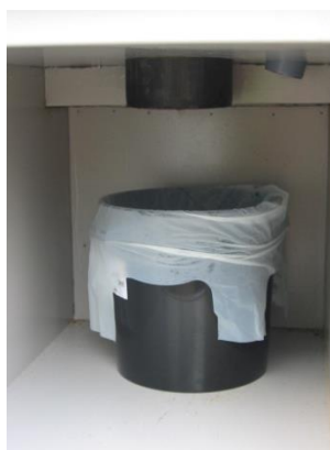
Figur 29. Exempel på urinsortande torrtoalett i porslin samt uppsamlingsbehållare för fekalier placerad i kryppgrund under toaletten.
