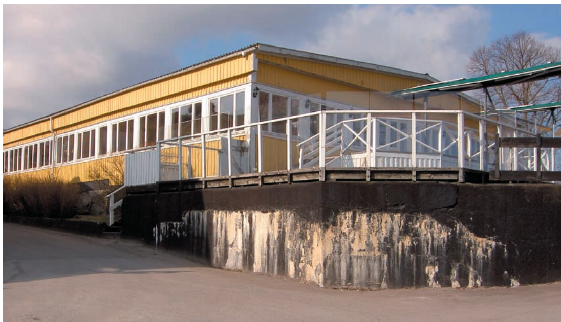
Hasselbacksbyggnaden med terrass och mur i förgrunden
