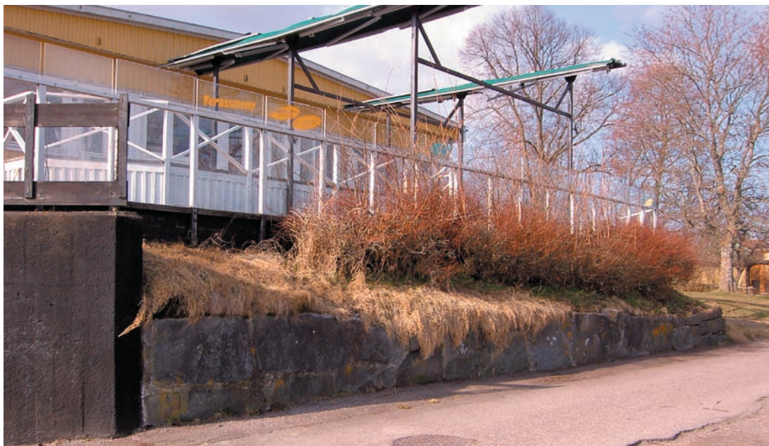
Mur och slänt mot norr
