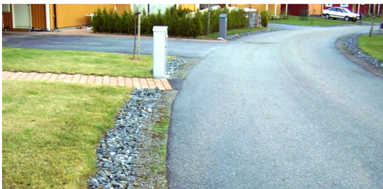
Figur 13. Principskiss och exempel på användning av makadamdiken mellan tomtmark och lokalgata. Källa: WRS (u.å.) och Stockholm Vatten och Avfall (u.å.).
