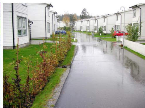
Figur 13. Principskiss och exempel på användning av makadamdiken mellan tomtmark och lokalgata. Källa: WRS (u.å.) och Stockholm Vatten och Avfall (u.å.).
