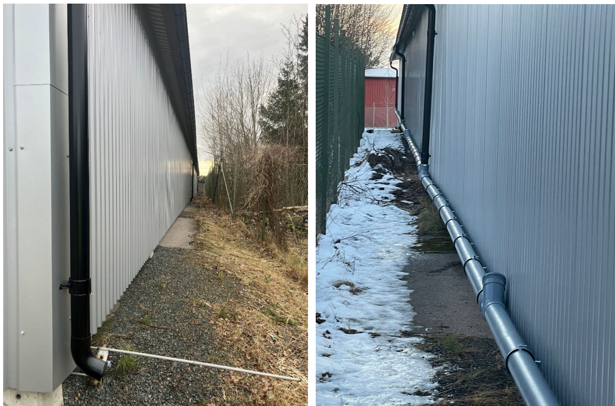
Före och efter. Vatten från utkastarna på carporten har samlats upp i rör. Dessa ska sedan anslutas mot stenkistan.
