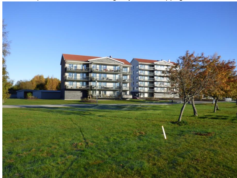
Norr om planområdet finns en fastighet som håller på att bebyggas med flerbostadshus.
