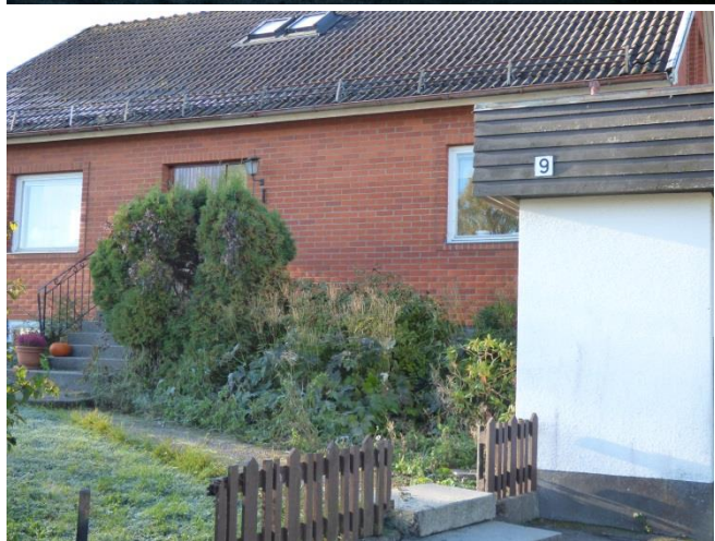
Villan på fastigheten 29:8.
