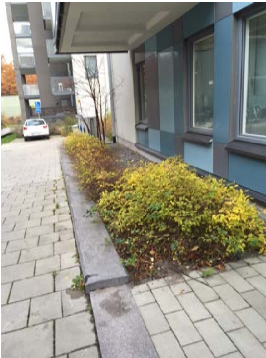
FIGUR 10. VÄXTBÄDD INTILL HUS, FÖR AVLEDNING AV DAGVATTEN FRÅN TAK.
