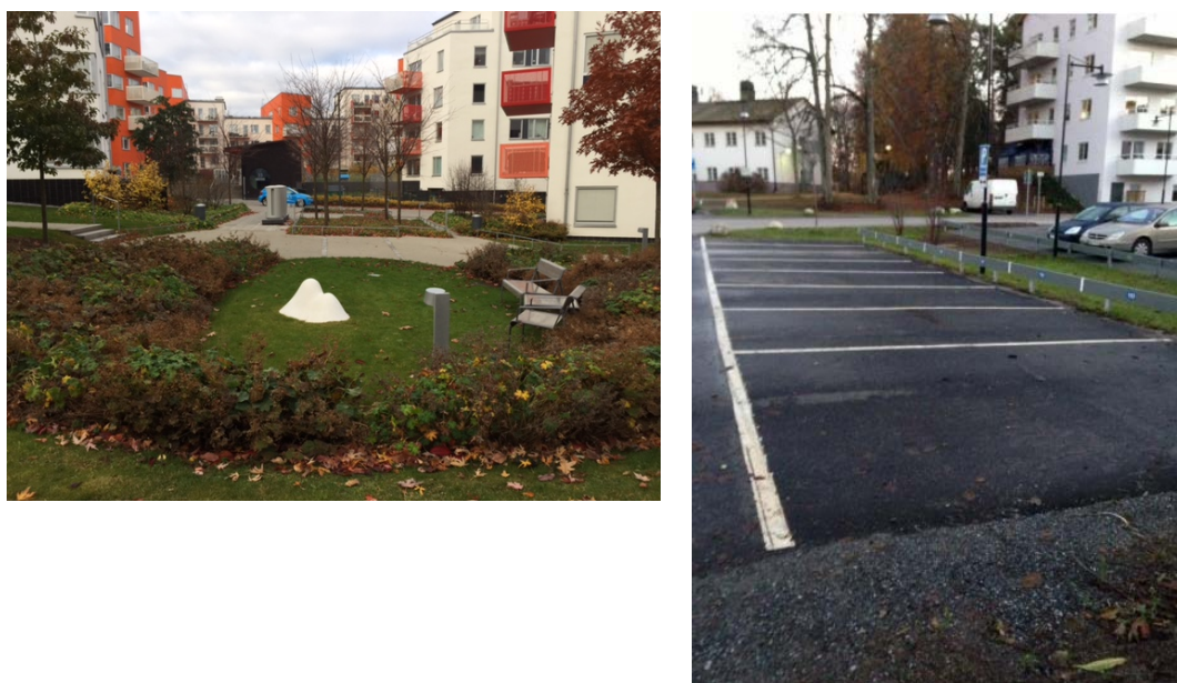
FIGUR 9. BILDER SOM VISAR HUR HÅRDCJORDA YTOR AVVATTNAS MOT GRÖNYTOR. I BILDEN TILL VÄNSTER EN NEDSÅNKT GRÖNYTA SOM AVVATTNAR OMKRINGLIGGANDE GÅNGVÄGAR. GRÖNYTAN HAR ANORDNATS MED BRÄDDMÖJLIGHET TILL DAGVATTENLEDNINGSNÄTET. I HÖGRA BILDEN VISAS EN HÅRDCJORD PARKERINGSYTA SOM AVVATTNAS TILL EN GRÖNYTA/INFILTRATIONSSTRÅK.
