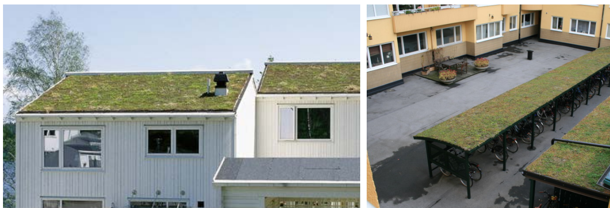
FIGUR 6. GRÖNA TAK PÅ HUVUDBYGGNAD OCH KOMPLEMENTBYGGNAD.
