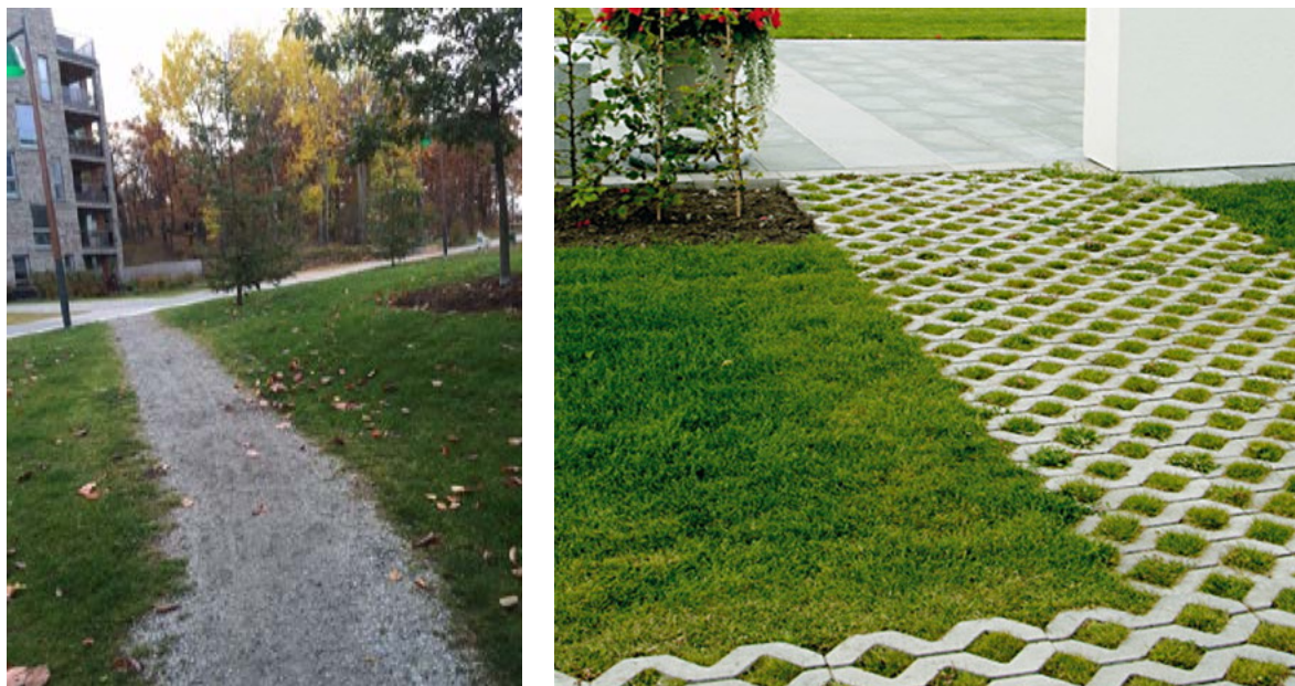
FIGUR 8. BILDER PÅ GENOMSLÄPPLIGA BELÄGGNINGAR. GRUSAD YTA I VÄNSTRA BILDEN, OCH MARKKARMERING I BETONG I HÖGRA BILDEN.
