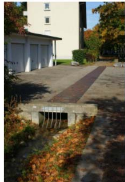
Exempel på i trädgårdsmiljöer integrerade och öppna dagvattensystem för infiltration och fördröjning.
