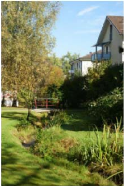
Exempel på i trädgårdsmiljöer integrerade och öppna dagvattensystem för infiltration och fördröjning.
