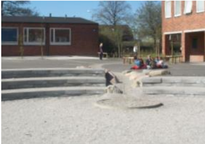
Figur 13. Överdämningsyta ovan mark (Stockholm vatten och avfall, 2019)
