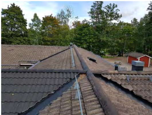
Översiktsbild över taket.
