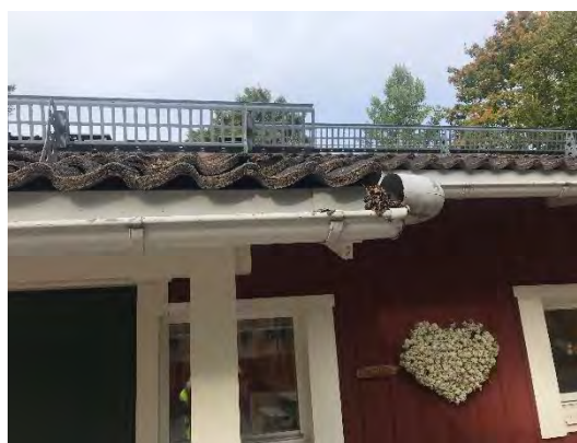
Stuprör och hängränna, skärmtak.
