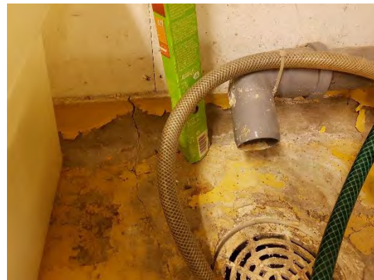
Golv undercentral (rum 44).
