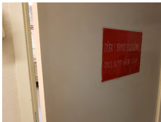
Anslag på dörr till kök "Dörr till brandcellsgräns skall alltid hållas stängd".
