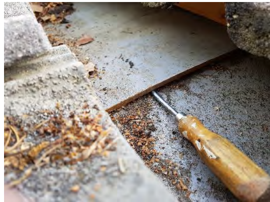
Masonitskiva under taktäckning
