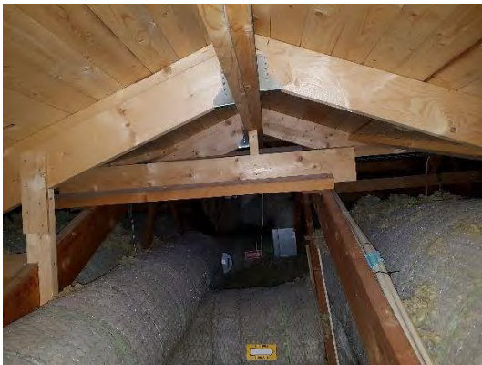
Översiktsbild vind sedd från fläktrummet.
