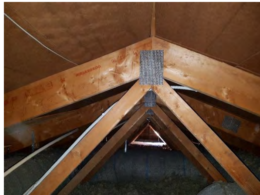
Översiktsbild vind ovan avdelning Kotten.
