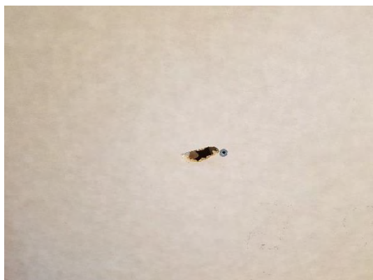
Uppslag i vägg i tvättrum (rum 03).
