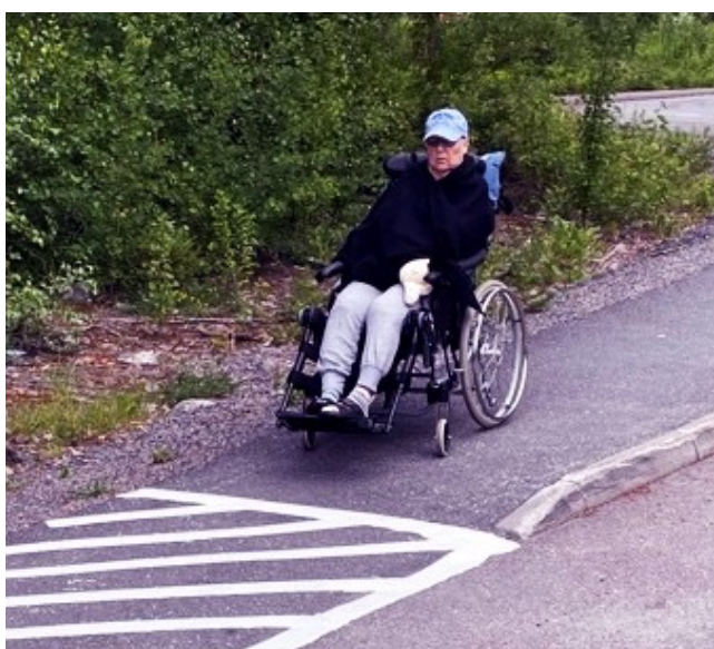
Parkerad bil nära trottoarens slut tvingar ut rullstolen över trottoarkanten. Lösningen blev en kraftig målning på parkeringsytan som visar område som ska lämnas fritt.
