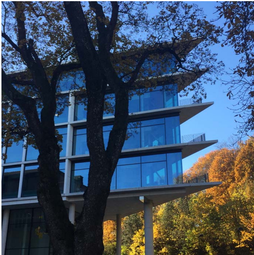
Psykiatrins hus, Landstinget i Uppsala län
