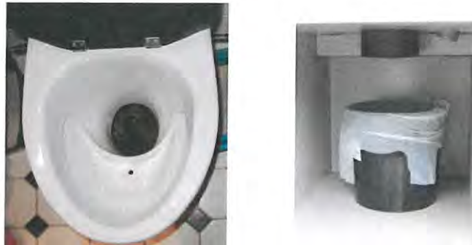
Figur 12. Exempel på urinsorterande torrtoalett i porslin samt uppsamlingsbehållare för fekalier placerad i kryppgrund under toaletten.
