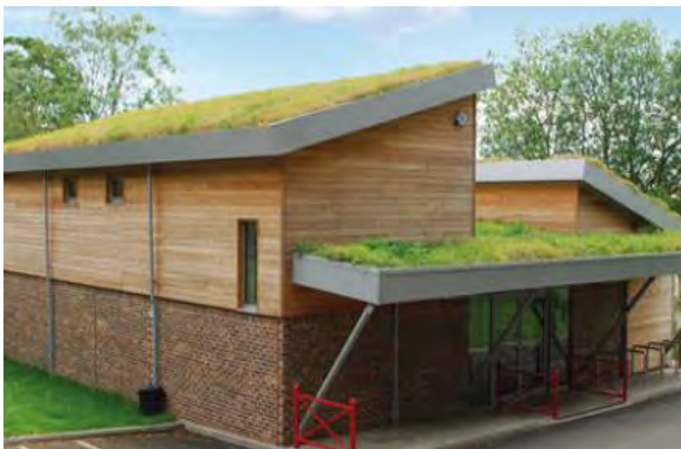
Figur 10. Sedumtak kan anläggas på både platta och lutande tak (Svenska Naturtak AB, 2017)
