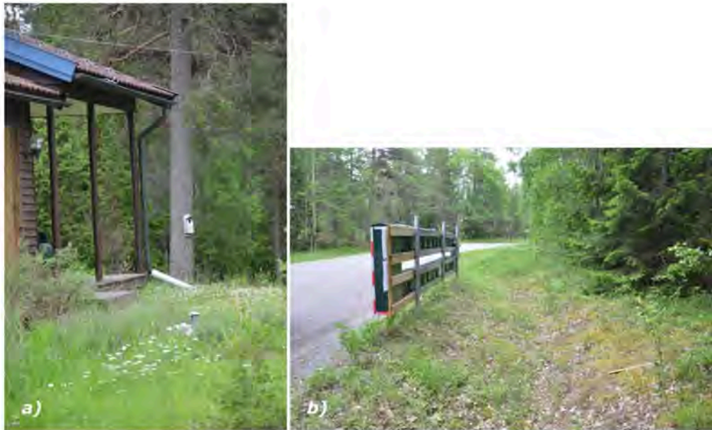
Figur 5a) Takvatten från stuprör som leds ut på mark. b) Vägdikey i området.
