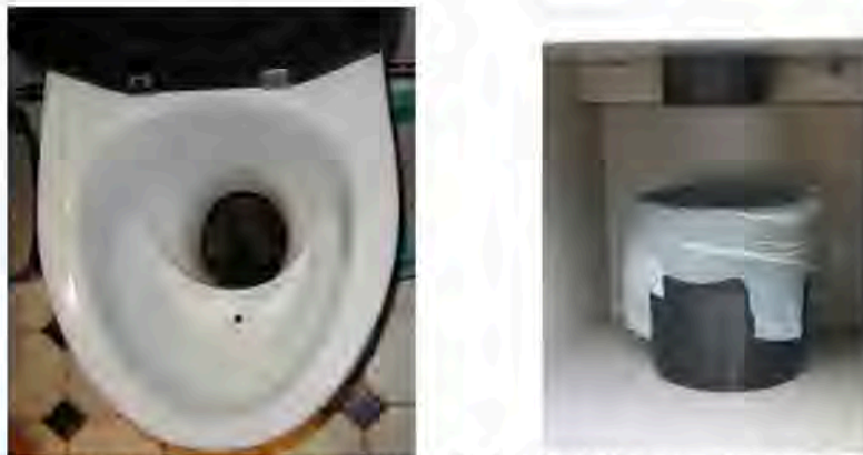
Figur 29. Exempel på urinsortande torrtoalett i porcelin samt uppsamlingsbehållare för fekalier placerad i kryppgrund under toaletten.
