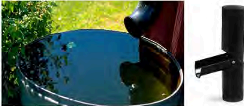
Figur 8. En enkel regntunna som fångar upp takvattnet. Foto: Stockholms stad. Fällbar utkastare för periodvis uppsamling i regntunna, t.ex. för fritidshus som bara bebos delar av året. Foto: Plannja.se.
