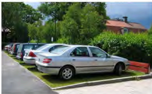
Figur 7. Parkeringsplats med gräsarmering i form av ett raster av plast ("Pelleplatta") täckt med gräs. Foto: Veg Tech AB 3 .
