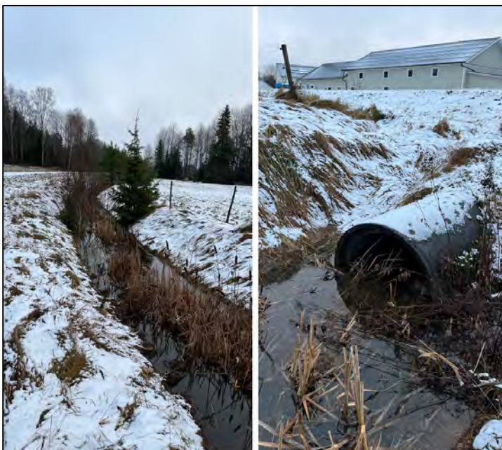
Figur 10. Befintligt dike i planområdes södra del
