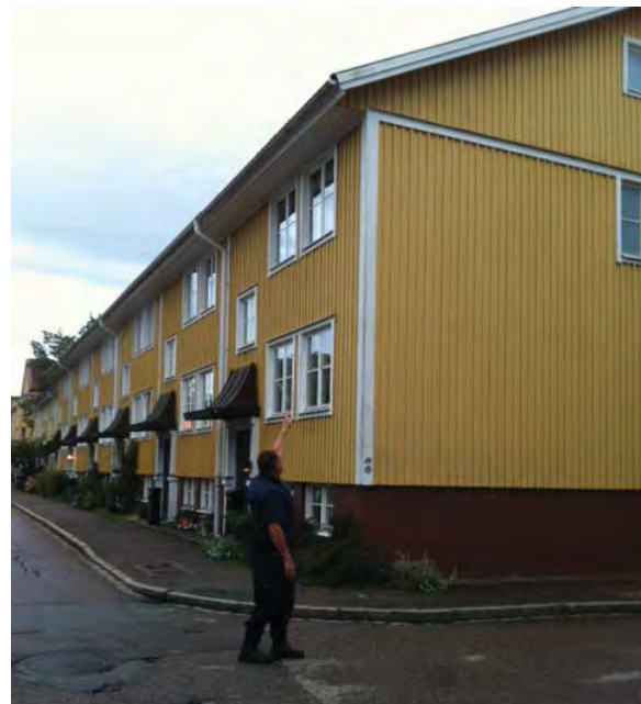
Inspektion av radhusvind 2015 i Uppsala.
