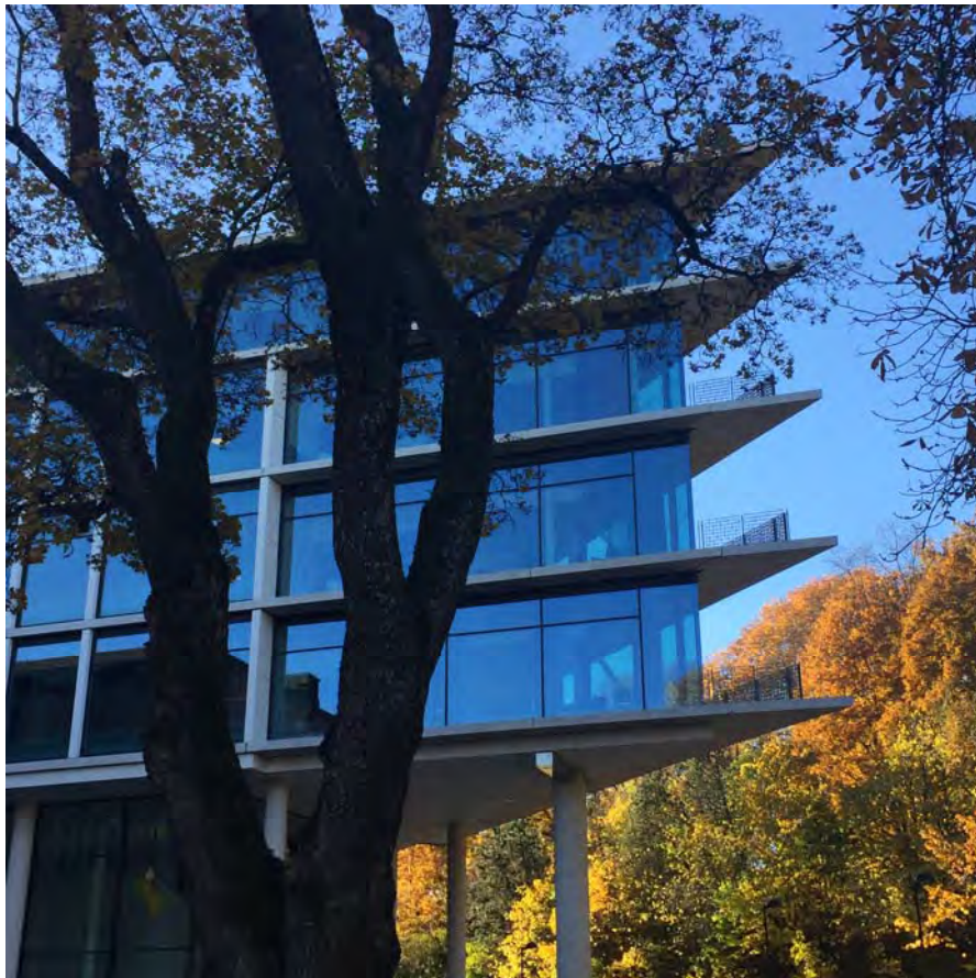
Psykiatrins hus, Landstinget i Uppsala län
