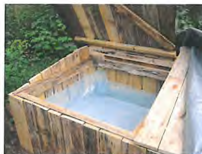
Figur 12. Fekalier från en urinsortering torrtoalett kan tas hand om på den egna tomten, genom kompostering i en latrinkompost.
