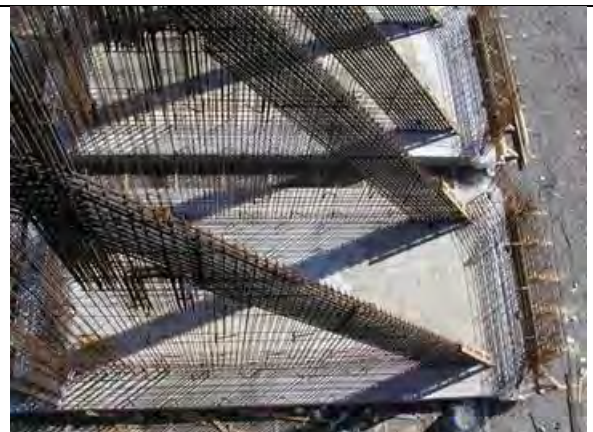
Figur 3. Bottenplattor gjutna och armering utförd för vägg och kontreforter. Klart för formsättning inför glidformsgjutning
