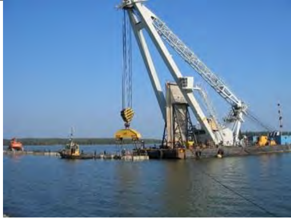
Figur 4. Stödmursegmenten lyfts på plats med stor pontonkran
