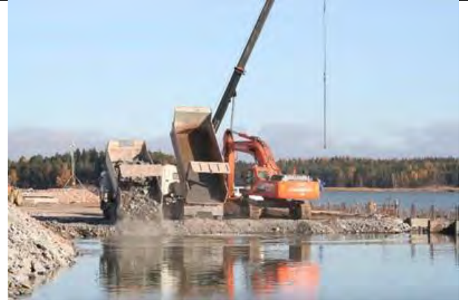
Figur 5. Utfyllnad mot och bakom stödmursegmenten
