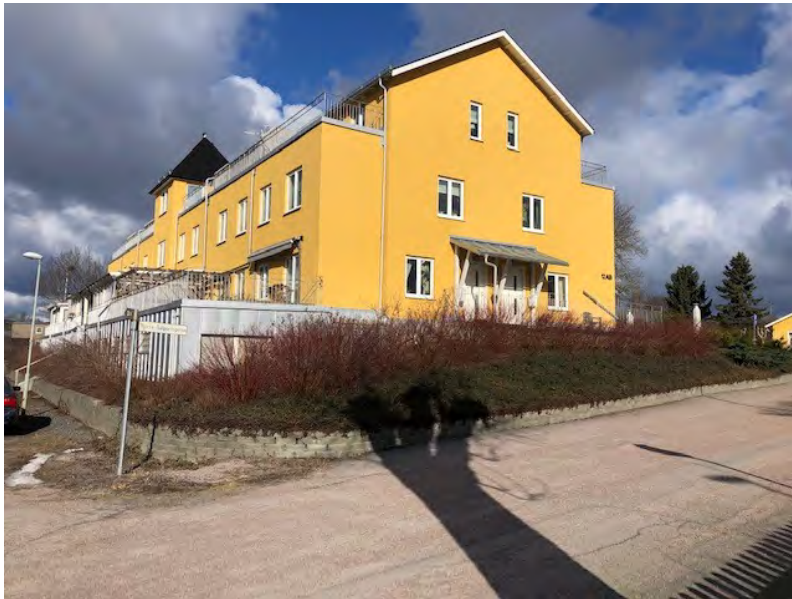
Fastigheterna ligger i en svag kulle. Vy från södra hörnet av planområdet.
