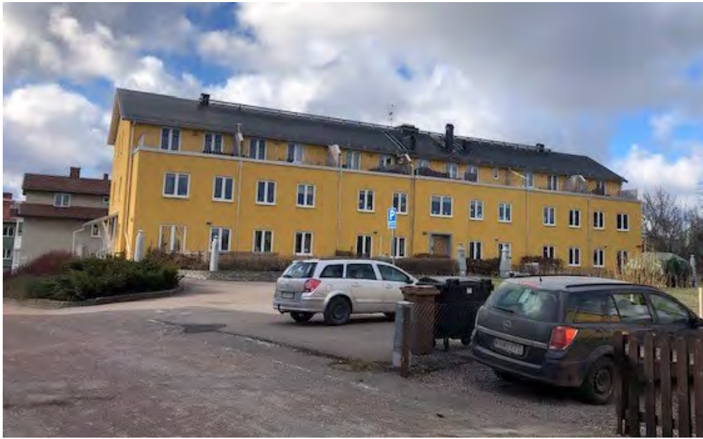
Altanernas läge uppe på byggnaden såsom det ser ut idag, utan inglasning.
