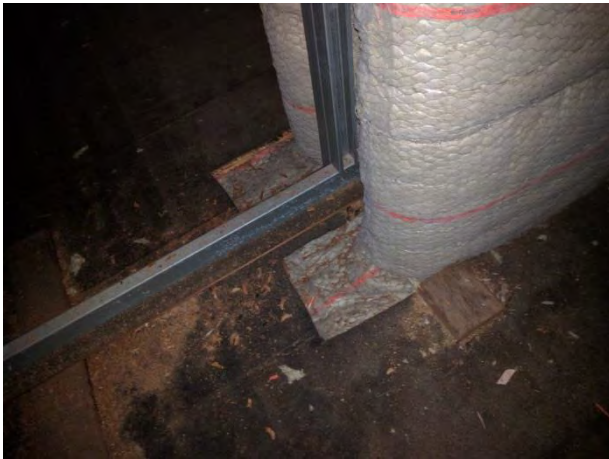
Foto 5 Genomföring för ventilation i låglutande papptak
