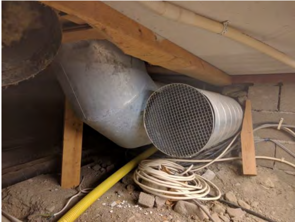
Foto 14 tilluftskanal i krypgrund
