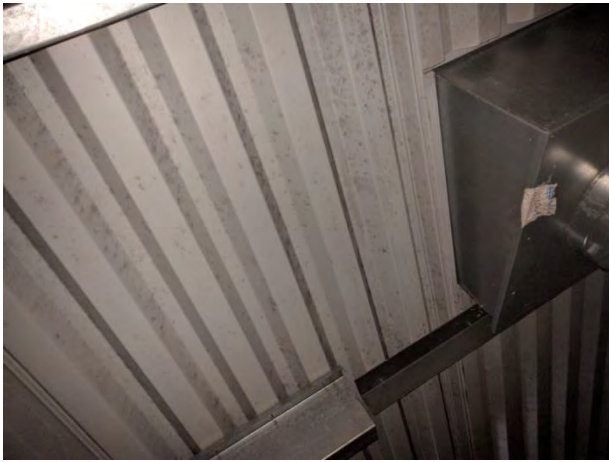
Foto 3 synlig mikrobiell påväxt på undersida plåt del 1
