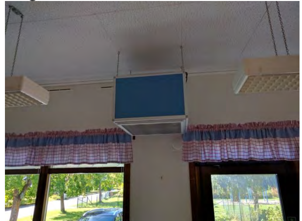
Foto 31 typ av fristående "dammfälla"?
