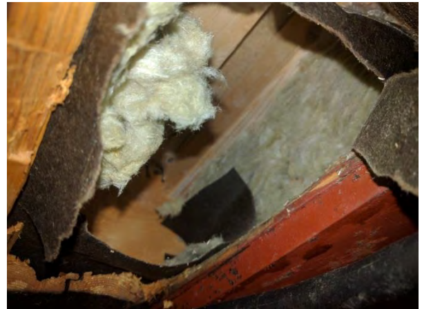
Foto 24 bild i bjälklag, ej skyddsmålat
