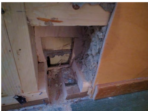
Foto 2 provhål i klassrum YV6
