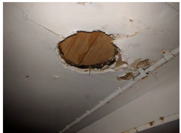
Foto 26 missfärgningar, tecken på tidigare läckage
