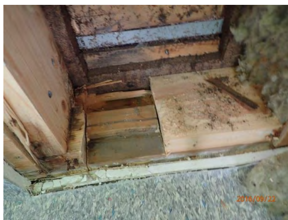
Foto 13 uttaget prov på syll i entre
