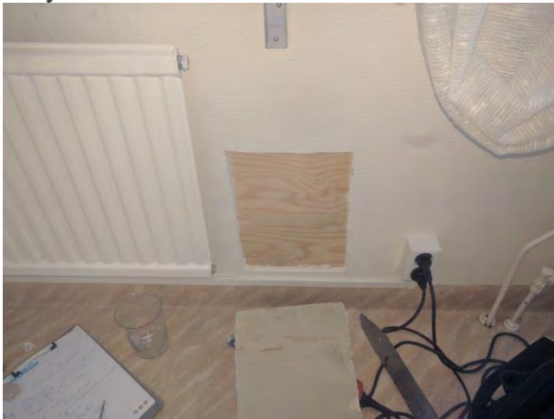
Foto 20 provhål med synliga skador (syns dåligt på bild)
