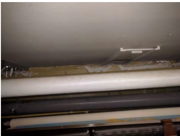
Foto 25 färg/puts läpp i vägg-/takvinkeln
