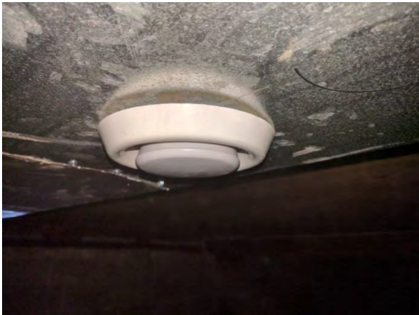
Foto 23 frånluftsdon i grund, ej i drift
