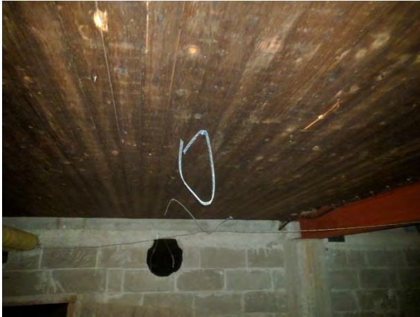
Foto 21 skyddsmålad undersida bjälklag
