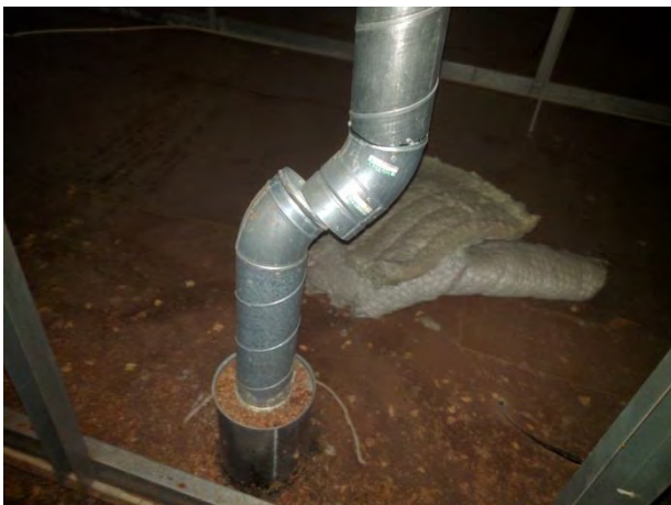
Foto 38 vent genomföring, ej ihopkopplad
