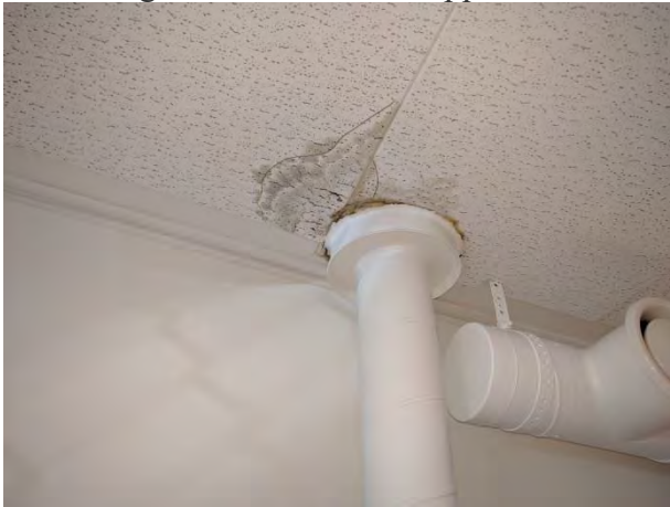
Foto 30 inläckage kring vent genomföring
