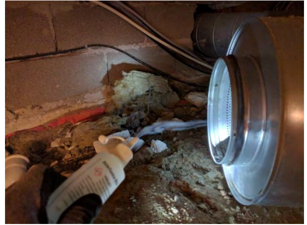
Foto 15 frånluftskanal i krypgrund
