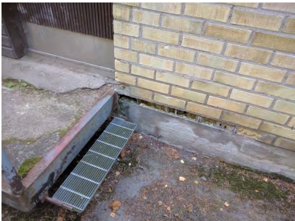
Foto 2 frostsprängning på tegel
