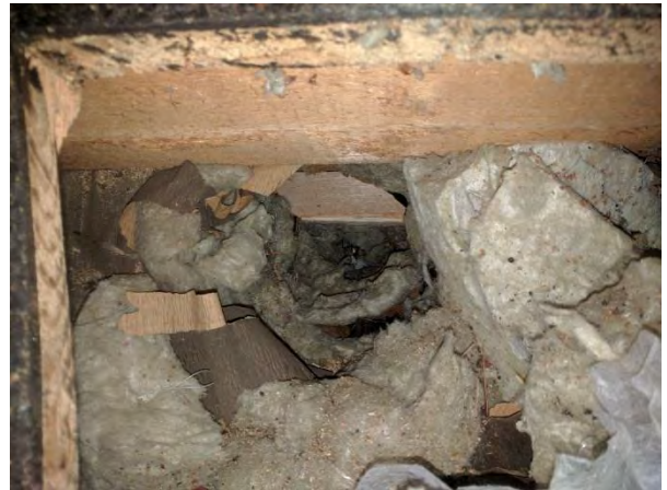
Foto 6 vindsbjälklag befintligt låglutande papptak
