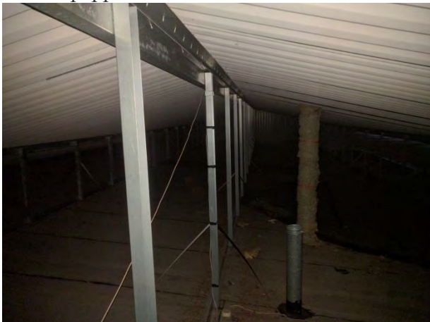
Foto 27 vybild över uppstolpat plåttak
