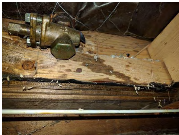
Foto 34 tydlig skyddsmålning av undersida bjälklag.
