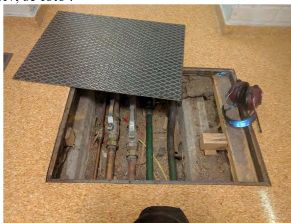
Foto 10 lucka i golv (provpunkt GP4)
