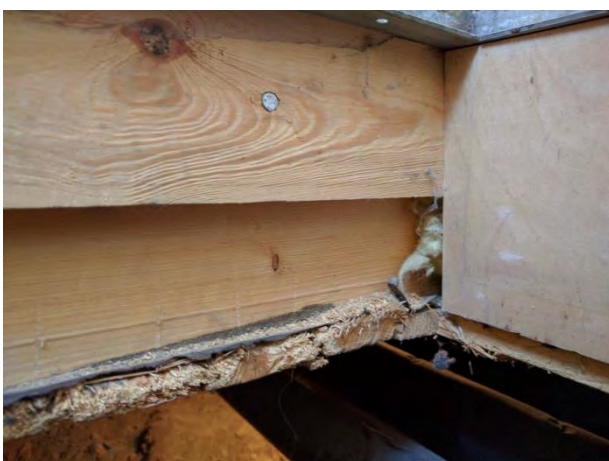
Foto 35 trä ej behandlat i bjälklag vid lucka till krypgrund
