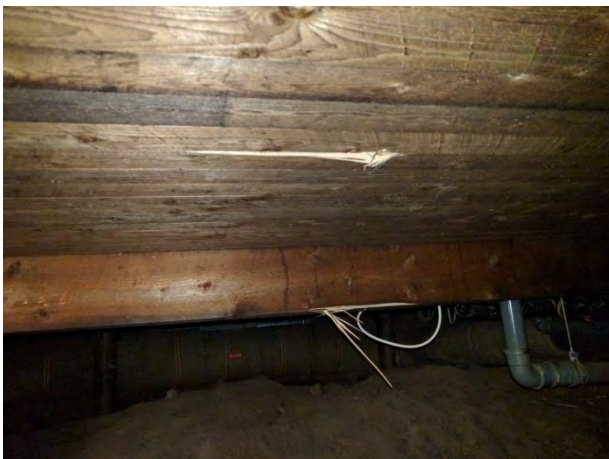
Foto 33 undersida bjälklag med uttaget prov, träskyddsmedel
