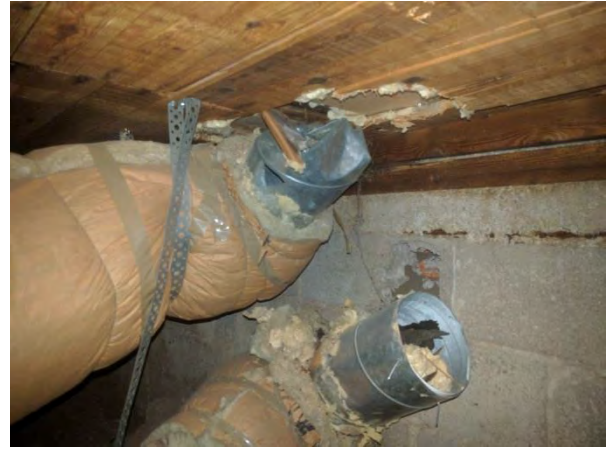
Foto 22 vent kanaler bortkopplade.
