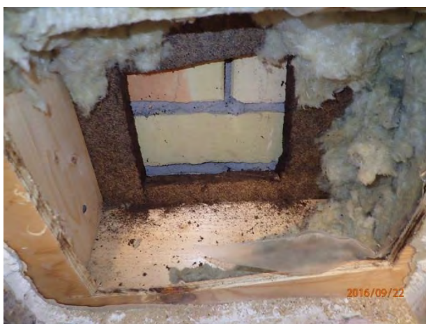
Foto 12 provhål i klassrum YV9
