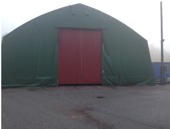
Figur 4. Salttältet i fastighetens östra del där förvaring av salt har skett. Idag används tältet som förråd.
