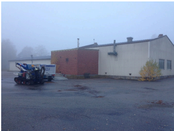
Figur 7. Baksida på förråd där förvaring av bl a bekämpningsmedel ska ha skett.
