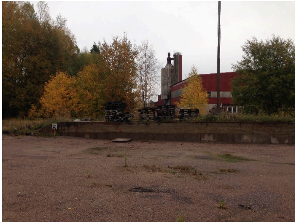
Figur 6. Upplagsyta med lastkaj bakom huvudbyggnaden, snett framför salttältet i fastighetens östra del.
