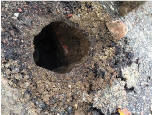
Figur 13. Tegel i marken i borrhunkt BH18, troligtvis rester från tidigare husgrund.
