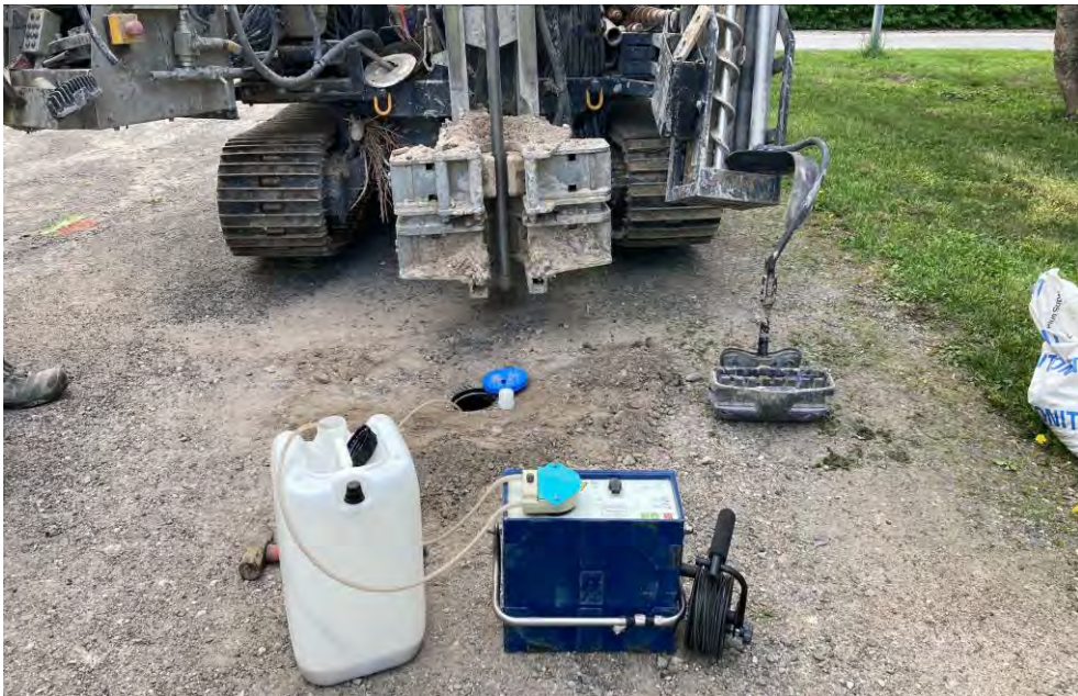
Renspumpning av grundvattenrör vid installation
