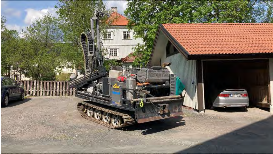
Jordprovtagning med geoteknisk borrhandsvagn
