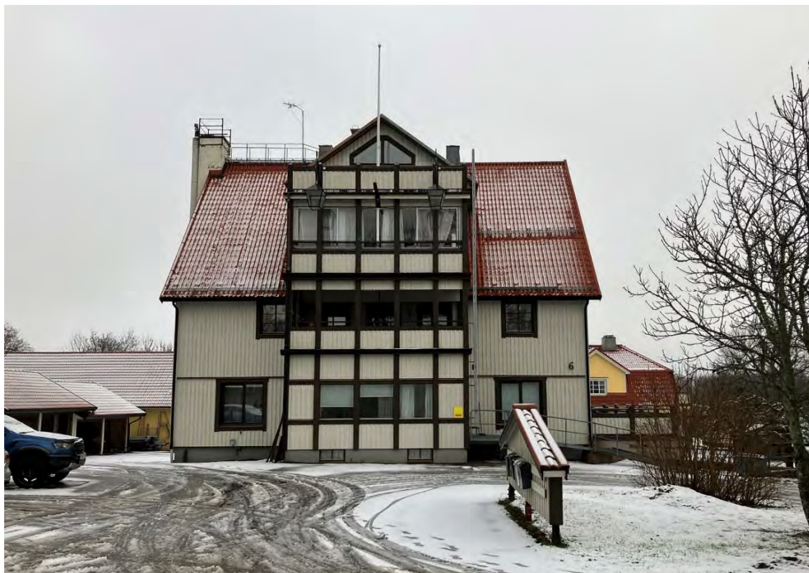
Den före detta brukshandeln, sedd från Hyttgatan.
