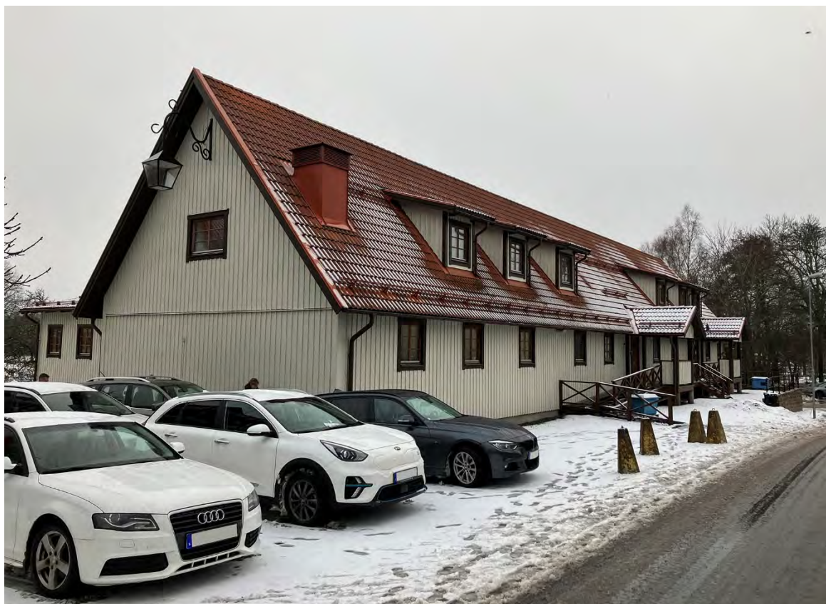
Kontorsbyggnaden sett från norr. Hyttgatan till höger.
