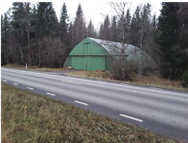
Figur 5 Den sydligaste av hangarerna. De tillhörde Gimobasen och togs i drift i början av 1960-talet och var till för bland annat flygplansreparationer. Bilden kommer från tidigare framtaget underlagsmaterial.
