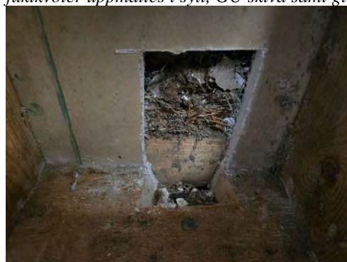
Foto 4 Löv/skräp i luftspalt i PP16. Förhöjda fuktnivåer uppmättes i syll, GU-skiva (indikation) samt i glesläkt
