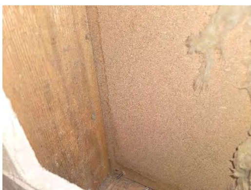
Foto 7 Provpunkt i nederkant med tydliga rinnmärken. Uttaget prov av träsyll påvisar mikrobiella skador.
