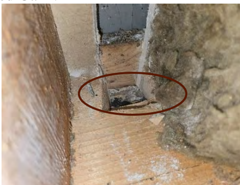
Foto 2 GU och syll ligger dikt an Leca i PP11. Förhöjda fuktkvoter uppmättes i syll, GU skiva samt glesläkt.
