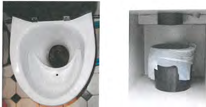
Figur 12. Exempel på urinsortande torrtoalett i porslin samt uppsamlingsbehållare för fekalier placerad i kryppgrund under toaletten.
