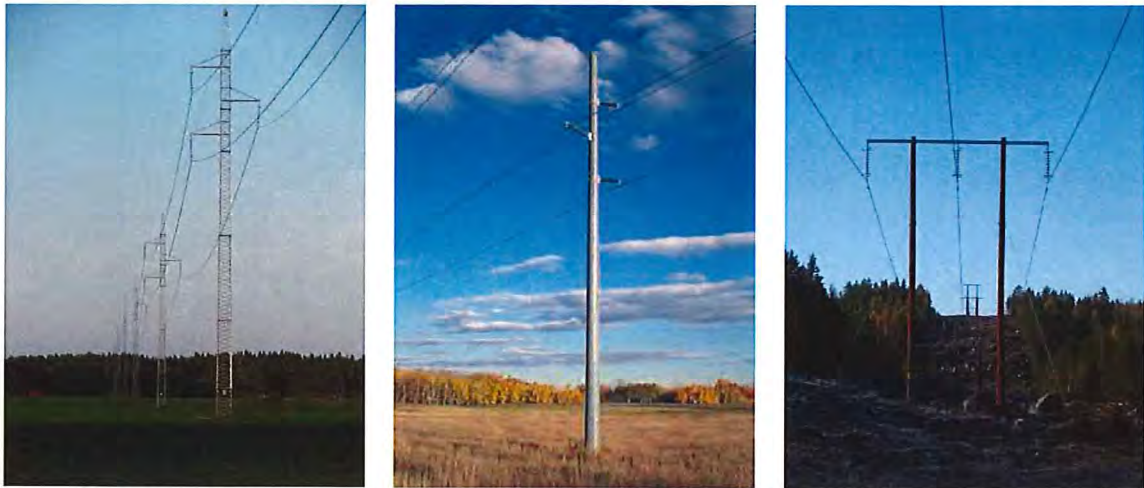
Figur 7. Exempel på olika stolptyper – stålstolpe, kompositstolpe och trästolpe.
