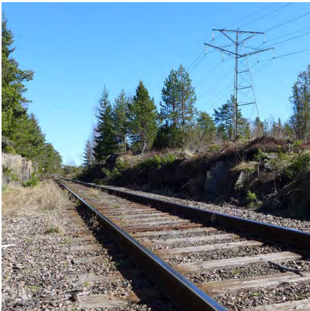
Figur 16. Befintlig ledning strax väster om kopplingsstationen i Harg, vy österut.
