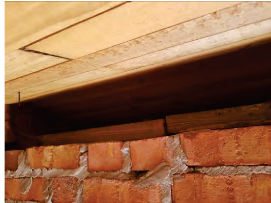
Till vänster; nedtrampad isolering på vinden. Till höger; tryckimpregnerat virke vid taknock.
