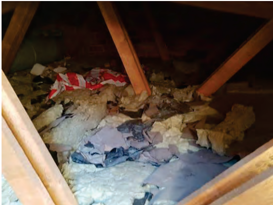
Till vänster; nedtrampad isolering på vinden. Till höger; tryckimpregnerat virke vid taknock.
