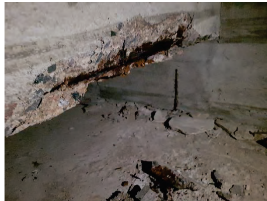
Till vänster; översiktsbild krypgrund. Till höger; rostande armering.
