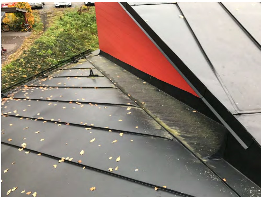
Foto 11. Byggnad 6, lokal algpåväxt på norra takfallet.
