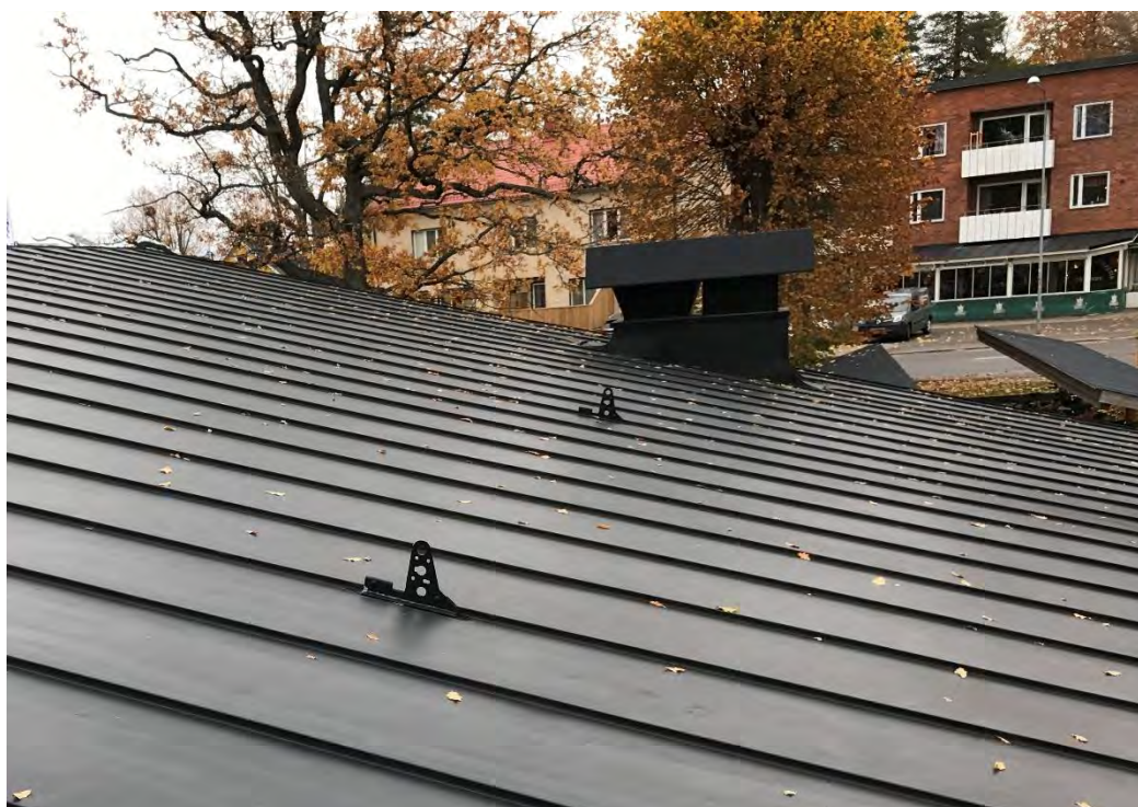
Foto 12. Byggnad 7, arbetsplattform saknas vid takfläkt.
