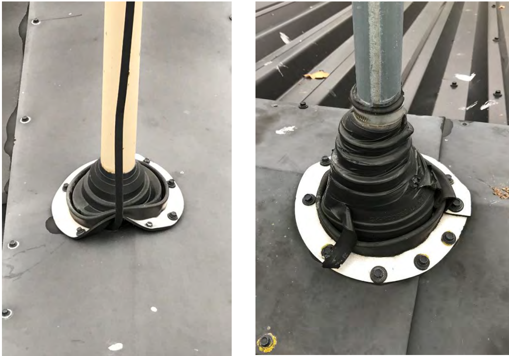
Foto 15. Genomföringar är otäta och ej fackmannamässigt utförda.
