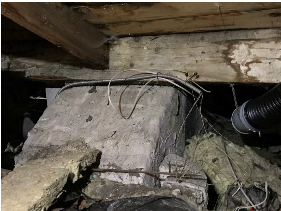
Foto 6. Lösa elinstallationer finns på högdelens vind.
