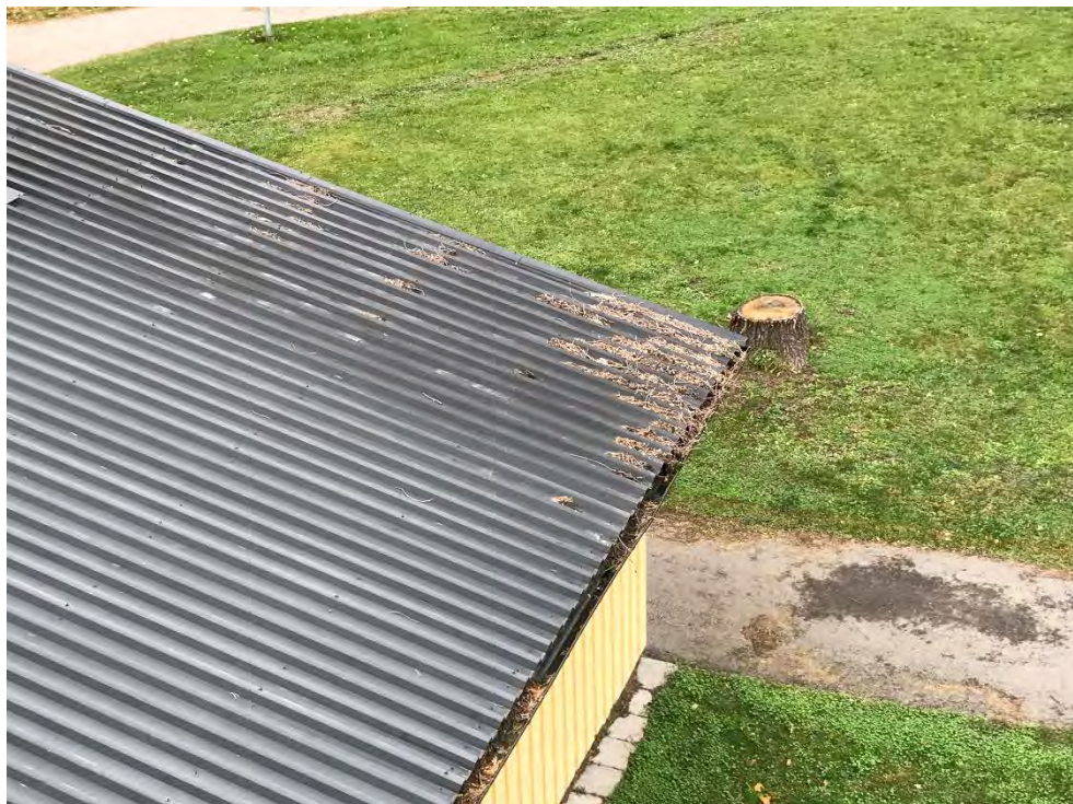
Foto 4. Hängerännor till tak ovan fläktrum är fulla med barr.
