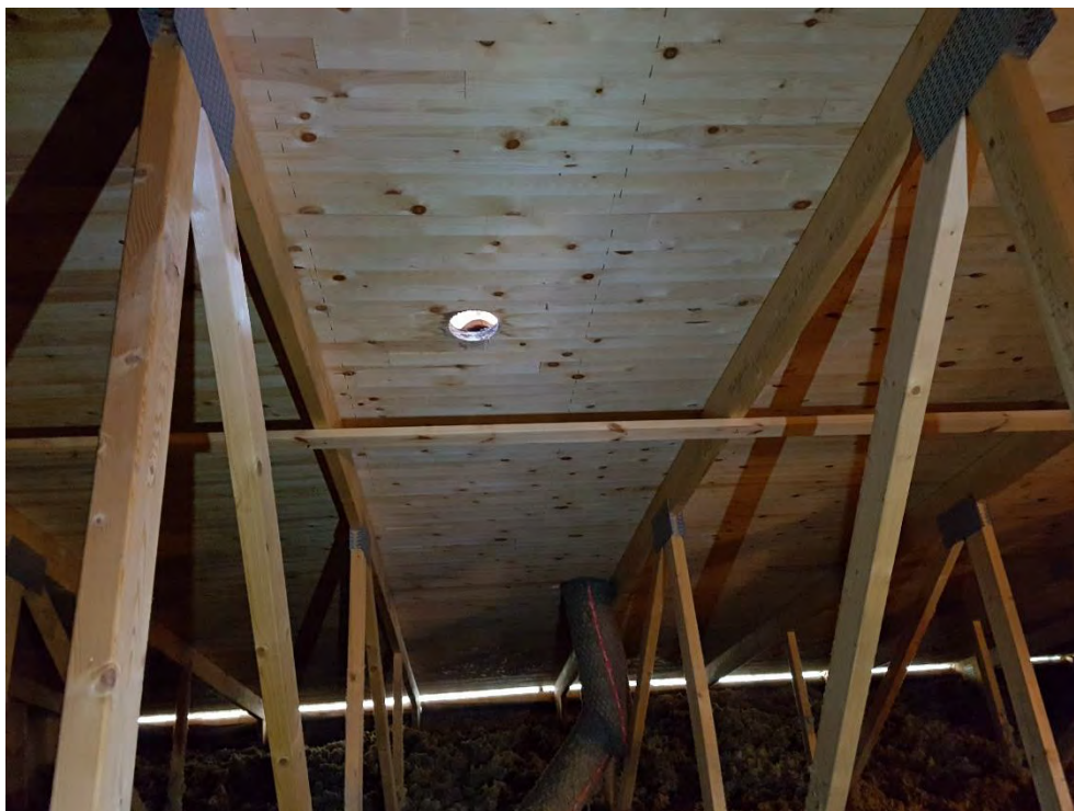
Foto 3. Hål i råsponten efter riven avluftning.
