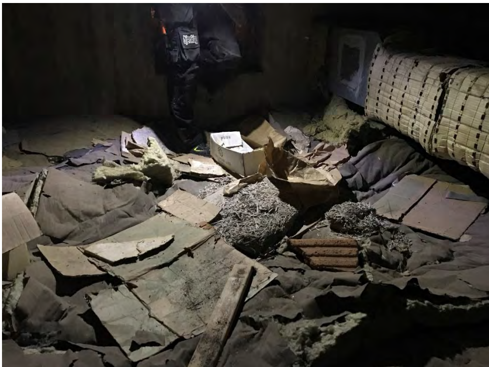
Foto 4. Byggskräp finns kvarlämnat på vindarna.
