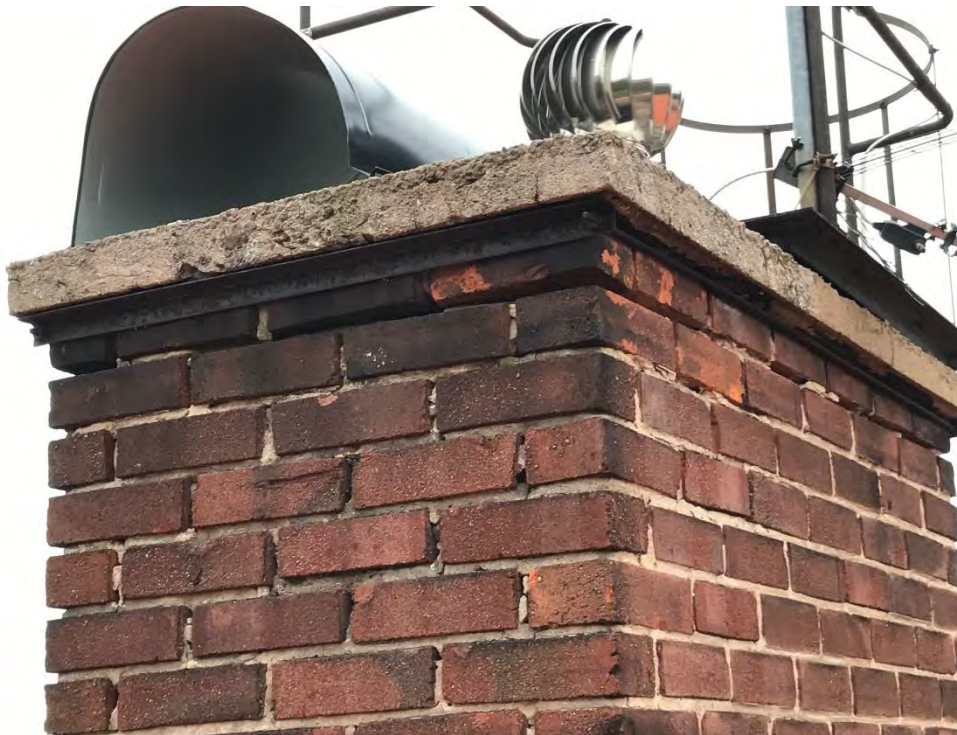
Foto 2. Fogbortfall på skorsten.
