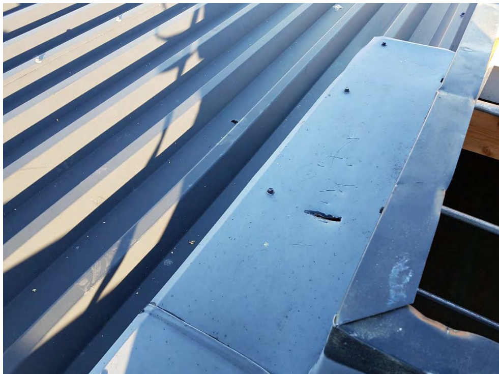
Foto 12. Hål i plåten i plåtbeslagning till taklucka på högdelen.
