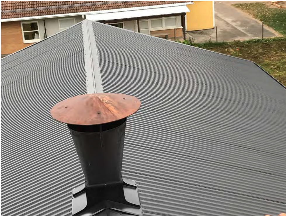
Foto 1. Omfattande färgflagning och rost på huv med äldre målad plåt.
