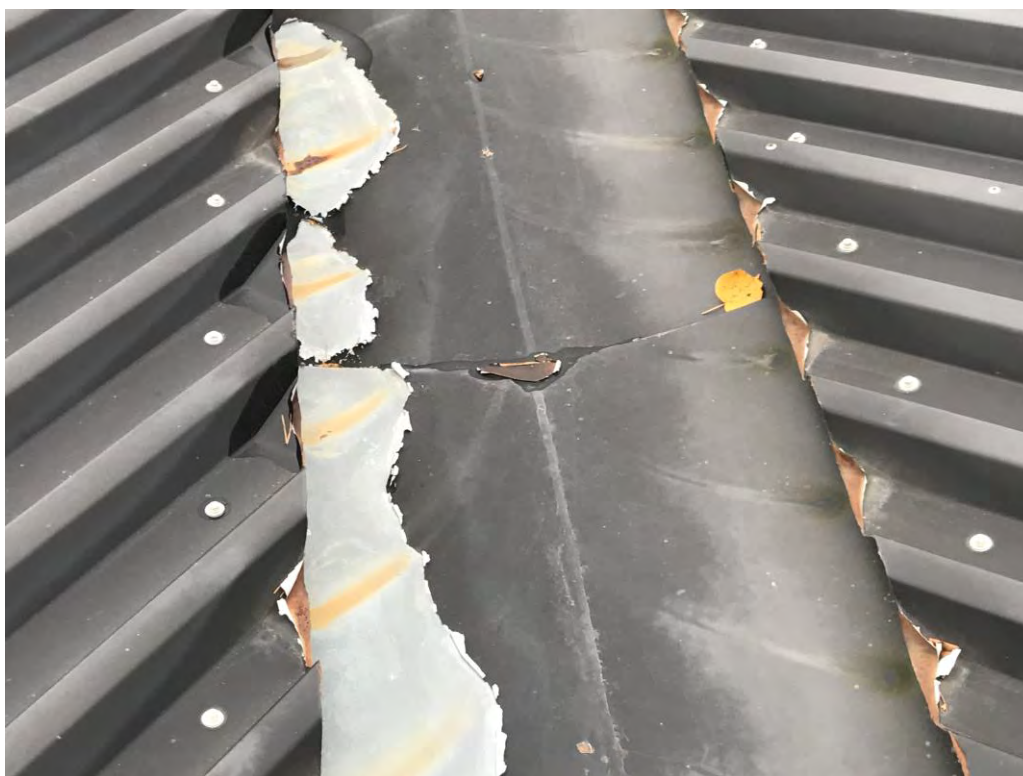
Foto 1. Belagd plåt rostar på kanter och i rännor.
