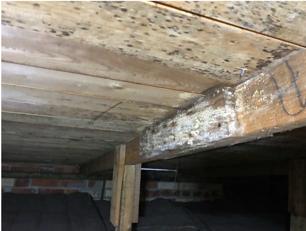
Foto 9. På vind 5.2 finns omfattande mikrobiell påväxt på undersida råspont.
