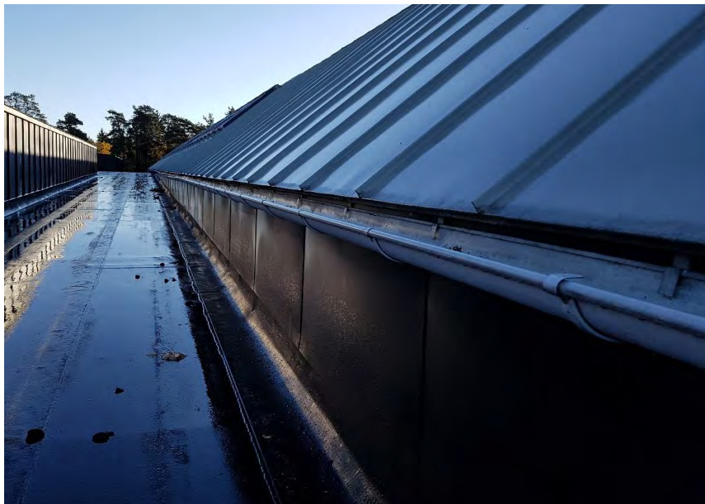
Foto 6. Hängrännor har felaktigt fall och det är för långt mellan stuprören.
