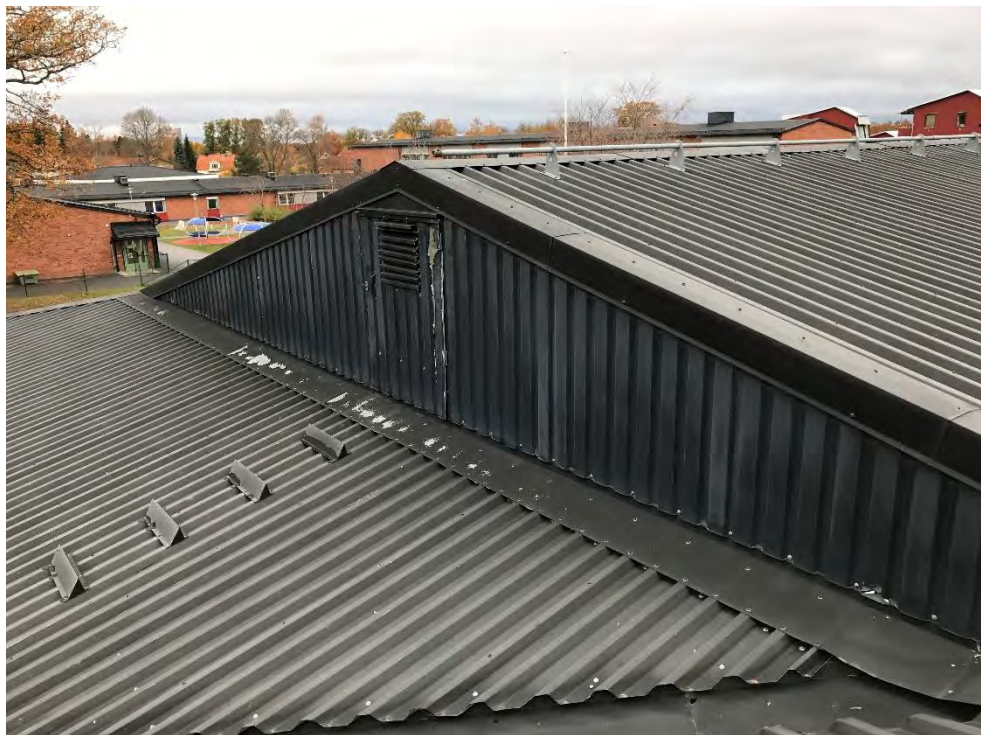
Foto 14. Beläggning släpper på väggbeklädnad och ståndplåtar.
