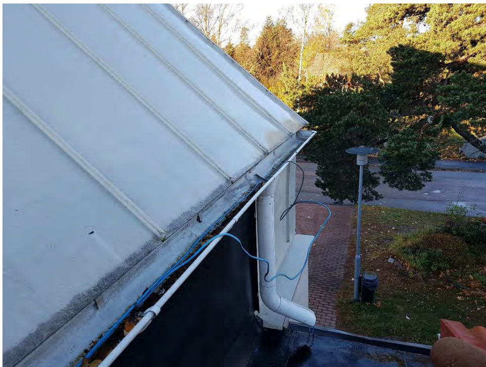
Foto 7. Elkabel i hängrännor är lös och hänger delvis utanför rännan.
