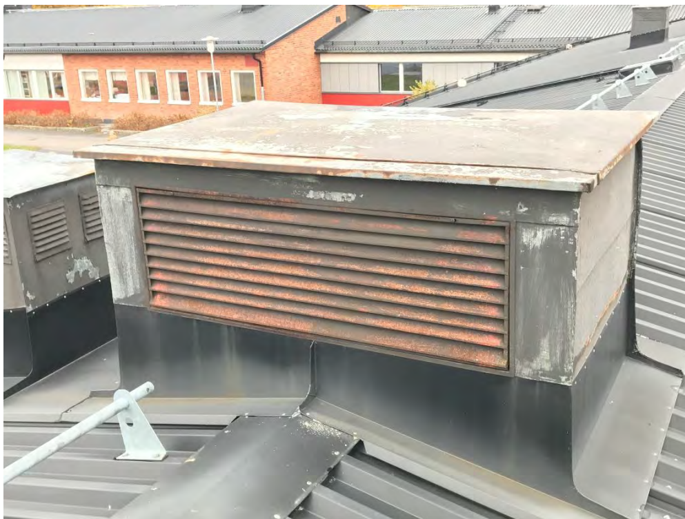
Foto 3. Kraftig färgflagnig på målad plåt, frilagd plåt rostar.
