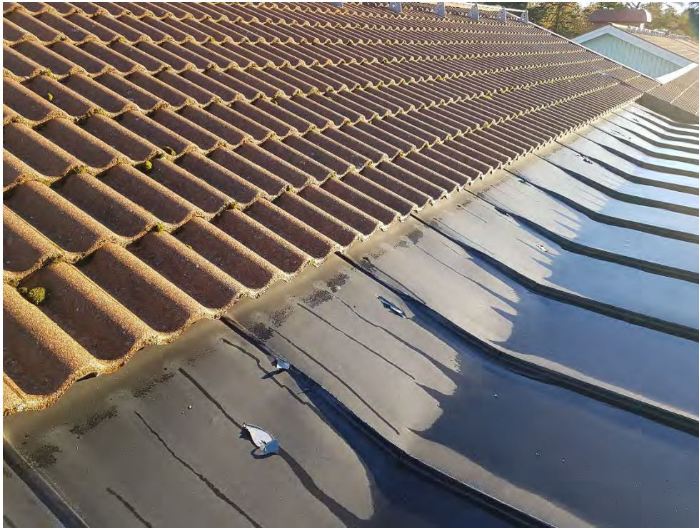
Foto 1. Beläggning släpper på takuppbyggnader
