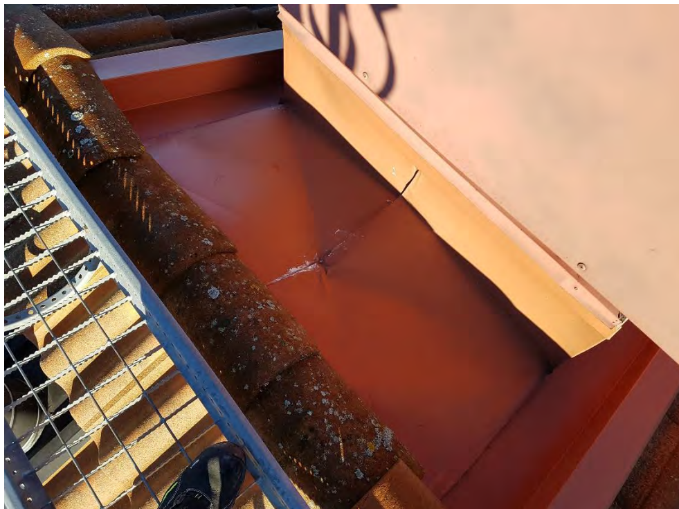
Foto 2. Plåt i skorstensränna till takhuv är söndertrampad.
