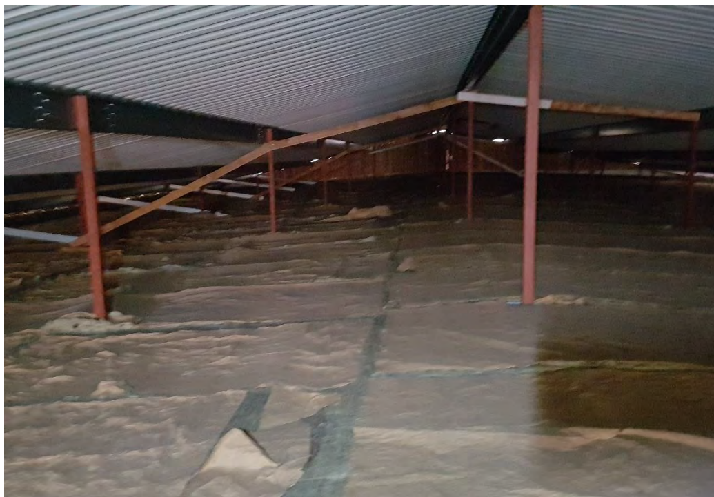
Foto 14. Gångbryggor saknas på vinden.
