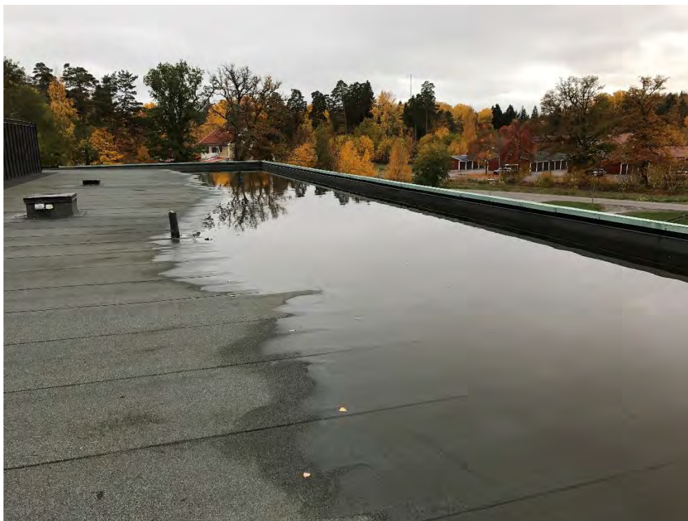
Foto 1. Stående vatten på låglutande tak med tätskiktsmatta.
