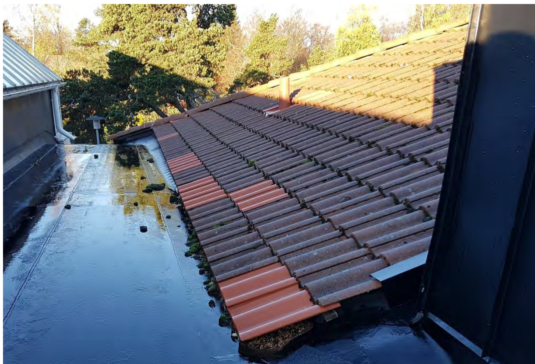
Foto 8. Påväxt av mossa finns i anslutning till takpannor.
