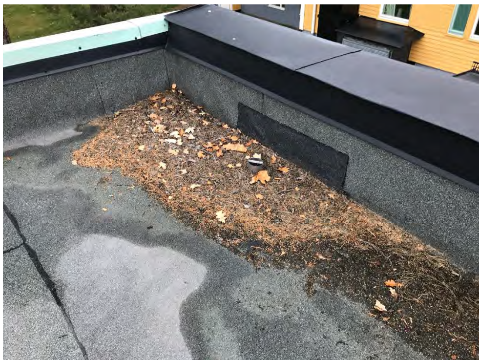
Foto 2. Takbrunnarna är igensatta med löv och barr.
