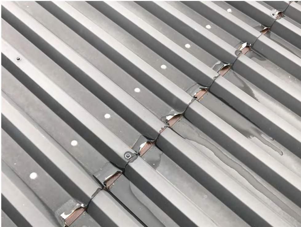
Foto 13. Beläggning släpper i skarvar på den trapetskorrugerade plåten.
