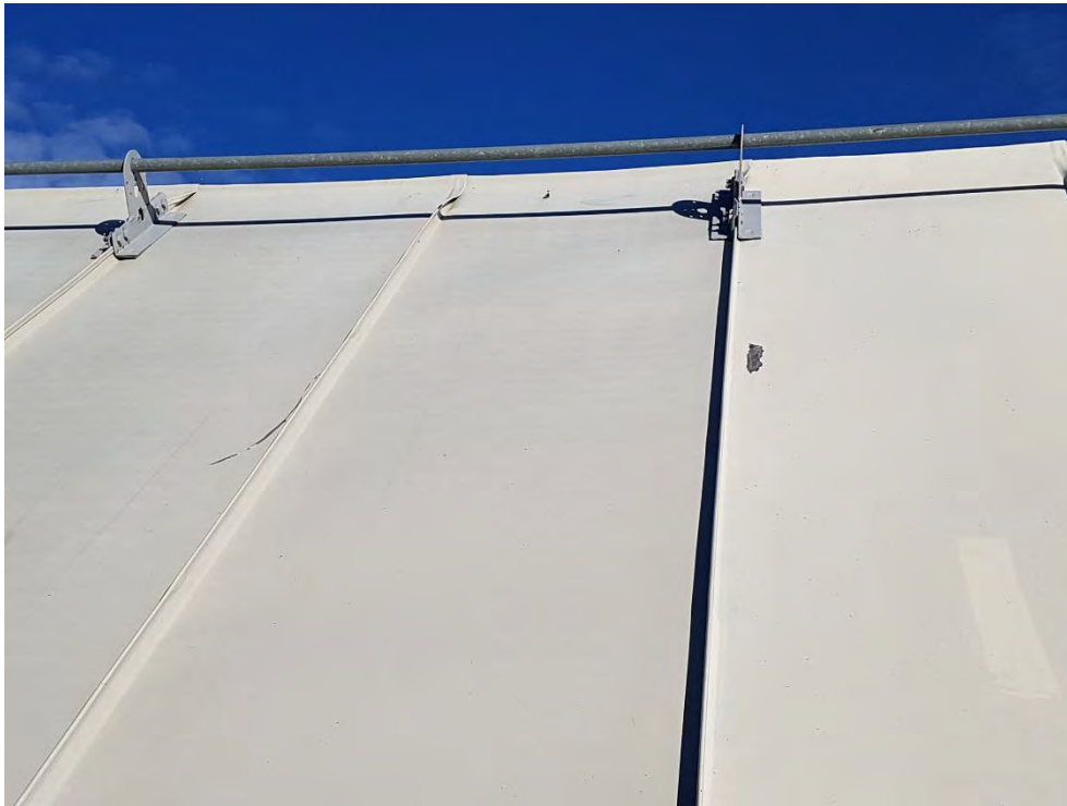
Foto 5. Skador finns på belagd plåt efter snöskotning.
