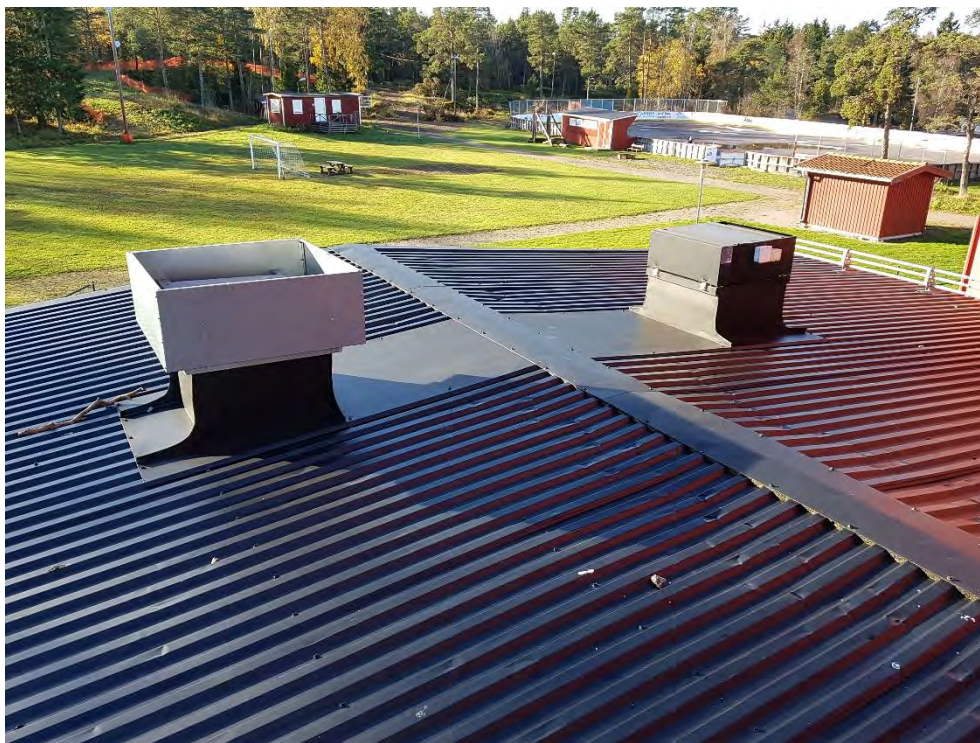
Foto 13. Plåten är deformerad i anslutning till takhuvar.
