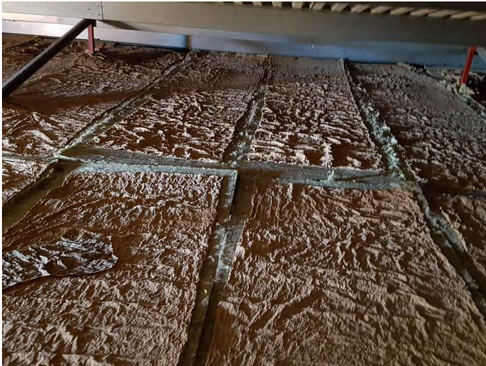
Foto 15. Vindsyddet på isoleringen är bubblig och har krympt.
