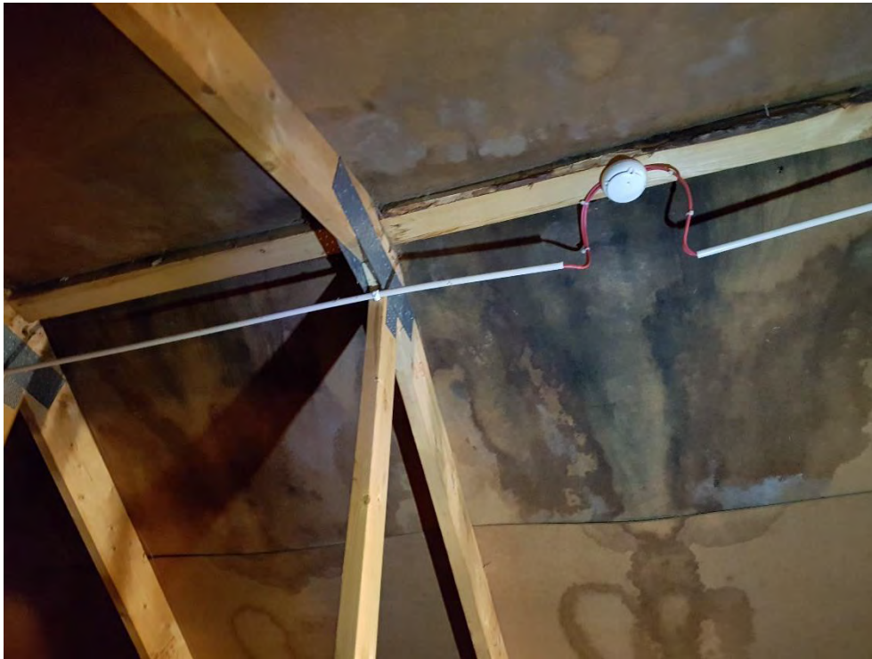
Foto 9. Omfattande fuktgenomträngning och mikrobiell påväxt på undersida masonit.
