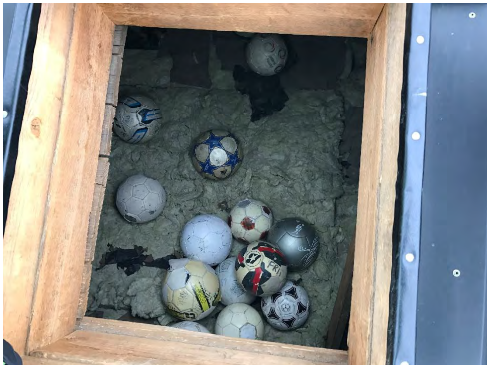
Foto 6. Vind ovan byggnad 4.
