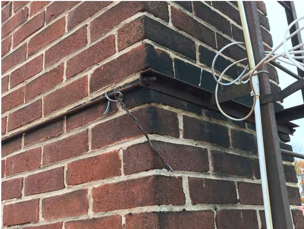
Foto 3. Stegens infästning kring skorstenen rostar.
