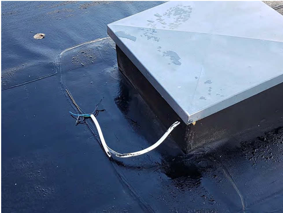
Foto 11. Lös elkabel vid taklucka, oklart om denna är strömförande.
