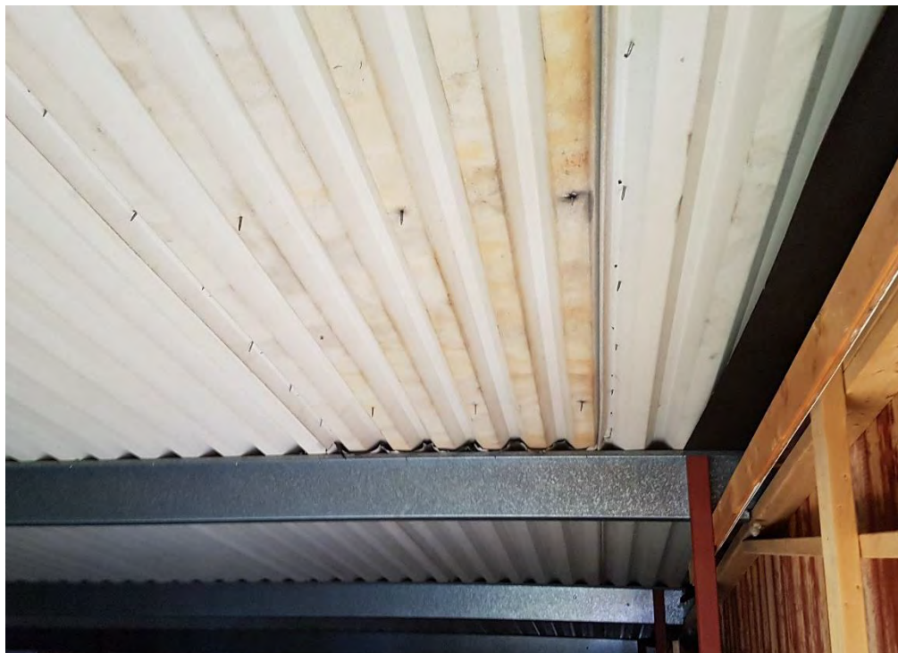
Foto 16. Lokala rinningar på undersida plåt.
