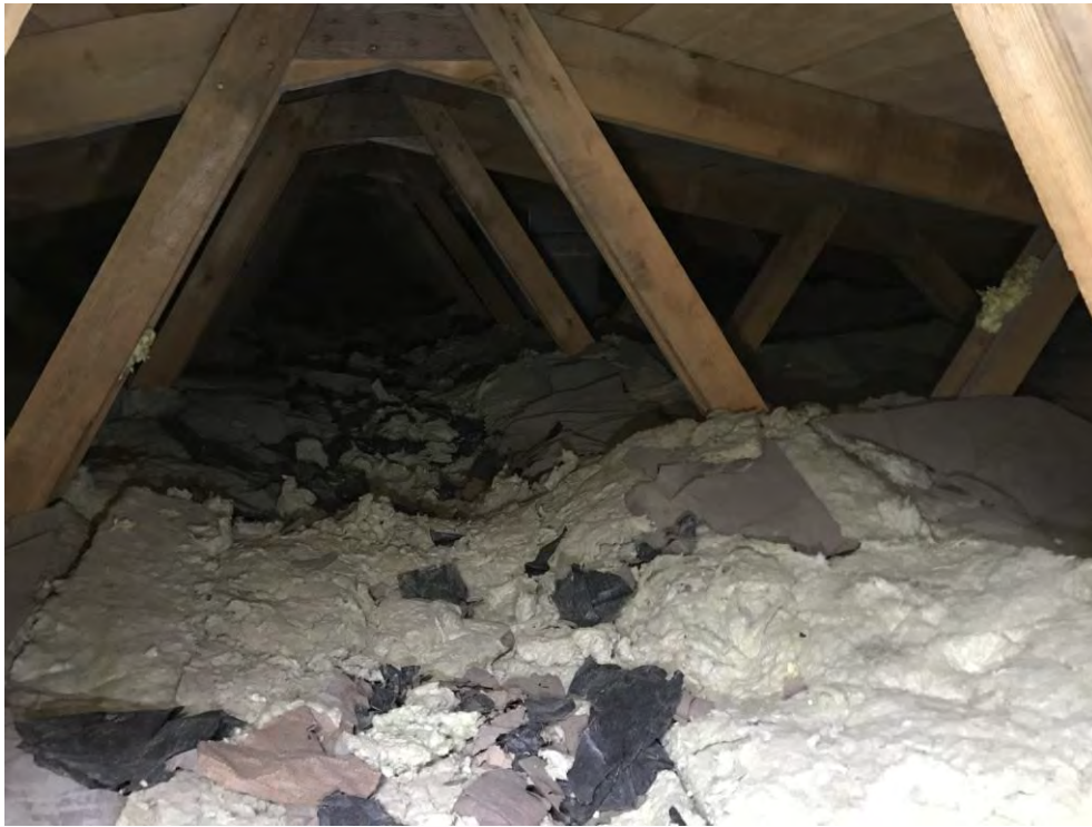
Foto 5. Isolering på vinden är nedtrampad.
