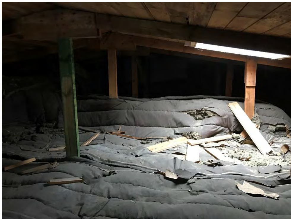
Foto 10. Mycket byggsräp har lämnats kvar på vindarna.
