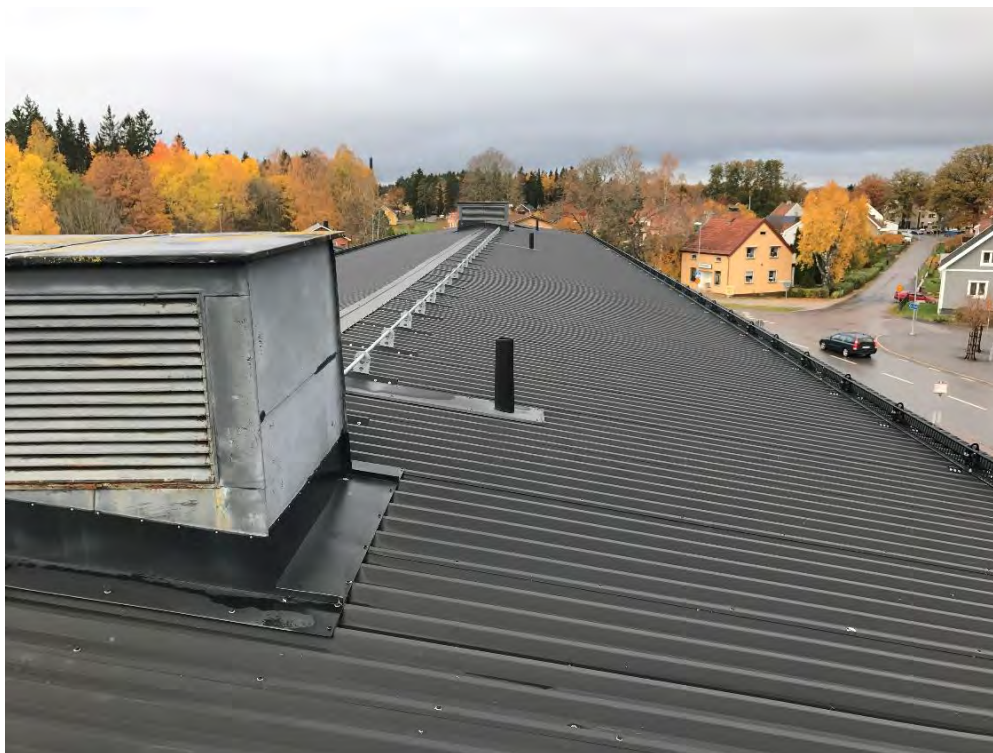
Foto 7. Äldre målad plåt rostar. Nockräckets placering mellan takhuvorna gör det svårt att förflytta sig på taket på ett säkert sätt.
