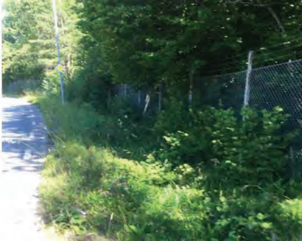
Bild 14. Befintligt dike längs Husbackavägen.
