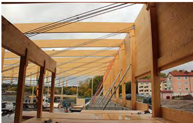
Bild X, Knivstas nya Centrum för Idrott och kultur byggs med trästommar vilket ger en lägre klimatpåverkan än betong.
