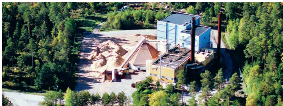
Bild X Fjärrvärmeverket i Knivsta, bild från Vattenfall Värme.
