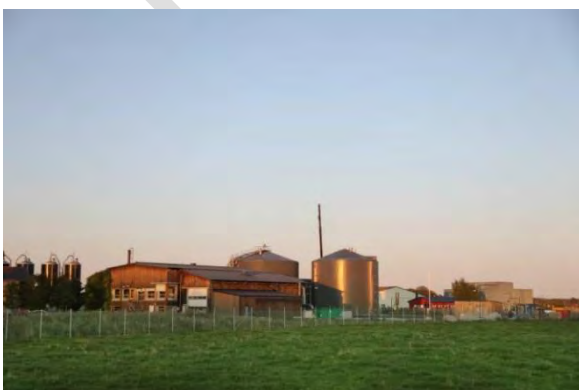
Bild X. Biogasanläggningen i Uppsala, bild från Uppsala Vatten och Avfall
