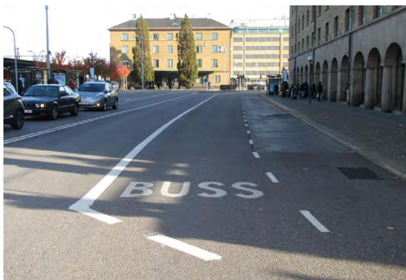
Figur 4. Exempel på gata med bilkörfält, busskörfält samt bussficka (källa: trafikistan.se).
