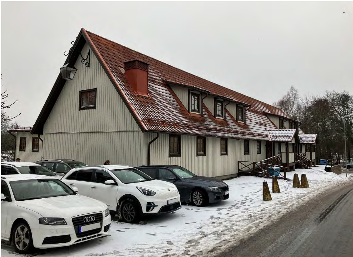
Kontorsbyggnaden sett från norr. Hyttgatan till höger.
