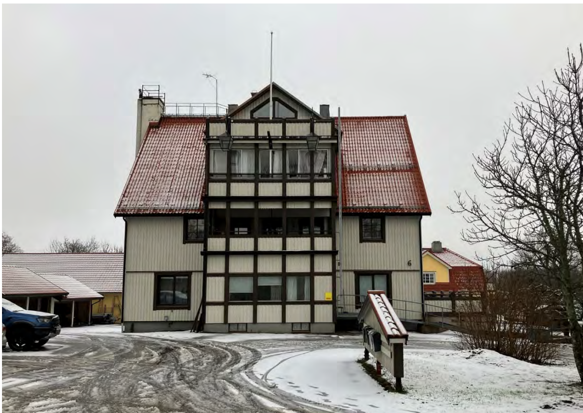
Den före detta brukshandeln, sedd från Hyttgatan.
