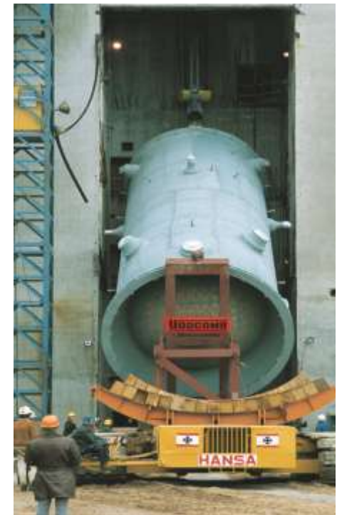
Installation av BWR-tank, BKAB
